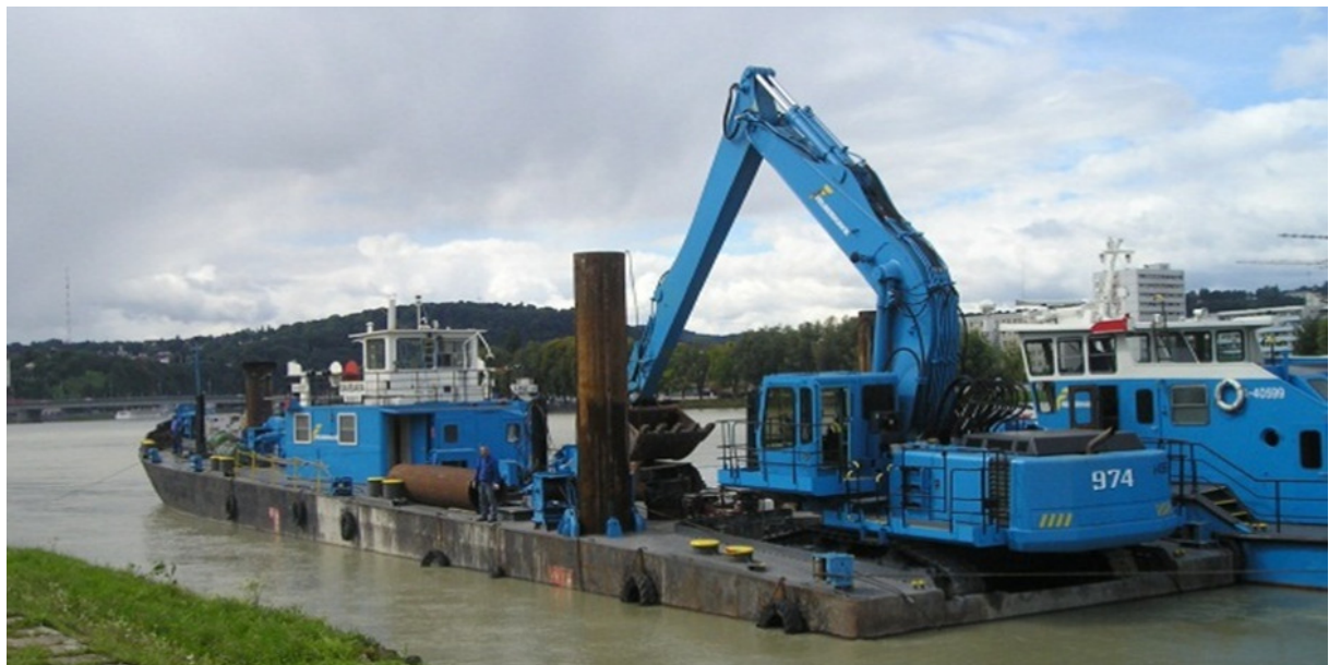
Abb. 20: Baggerstelzenponton und Liebherr R 974 (Fa. Felbermayr)
