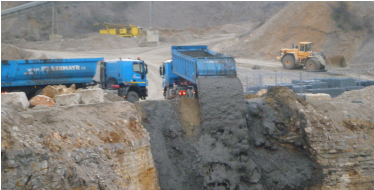
Abb. 51: Verfüllung des Steinbruchs Pfraundorf (Fa. Felbermayr)
