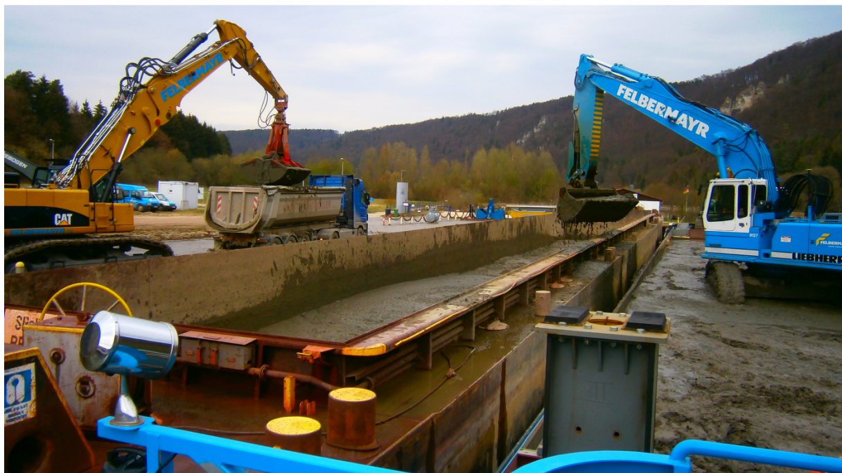
Abb. 23: Umschlagen von Baggergut über einen Schubleichter (Fa. Felbermayr)
