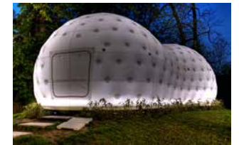
TEEHAUS FRANKFURT Kengo Kuma
