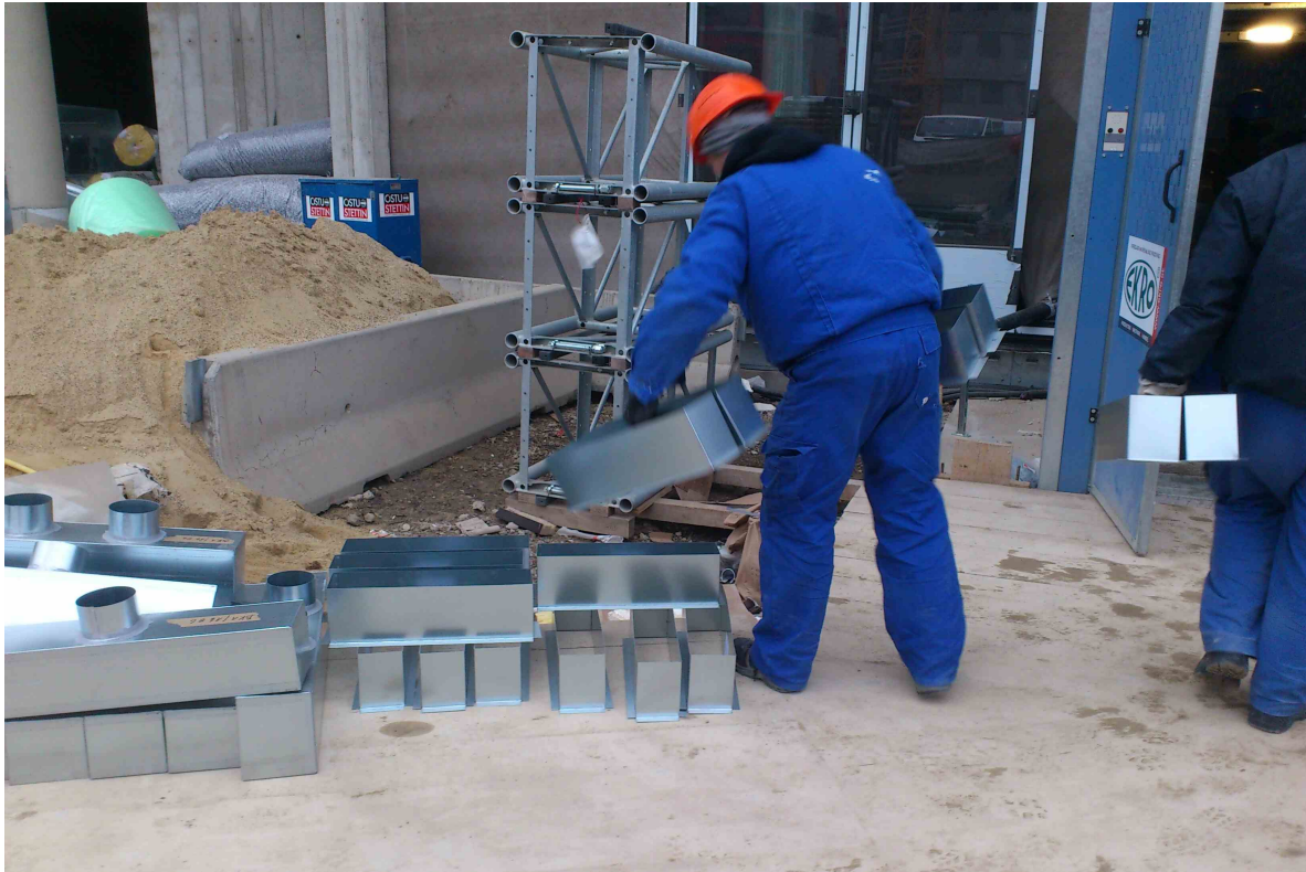
Abbildung 4.12: Handmanipulation von Lüftungsmaterialien
