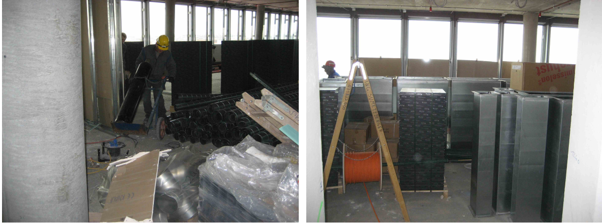
Abbildung 4.27: Materiallagerung diverser Bauprodukte 2
