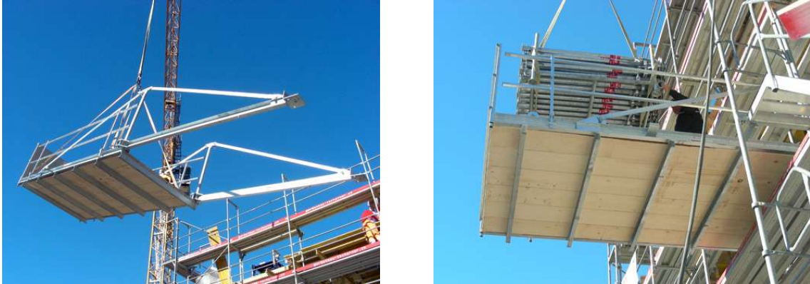
Abbildung 2.7: MS-Plattform (Mägert G&C Bautechnik AG) 62
