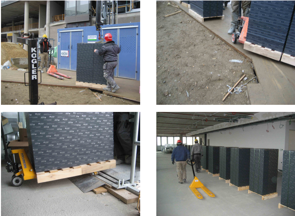
Abbildung 4.17: Istprozess der Materialmanipulation Doppelboden
