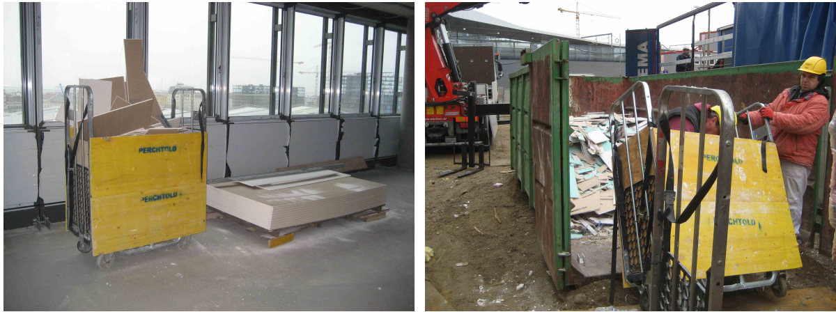
Abbildung 4.39: Entsorgung GKP-Verschnitt
