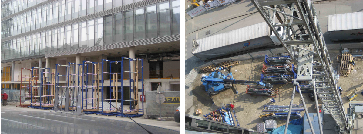
Abbildung 4.23: Lager Fassadenfertigteile, Lagerfläche D (links) B (rechts)
