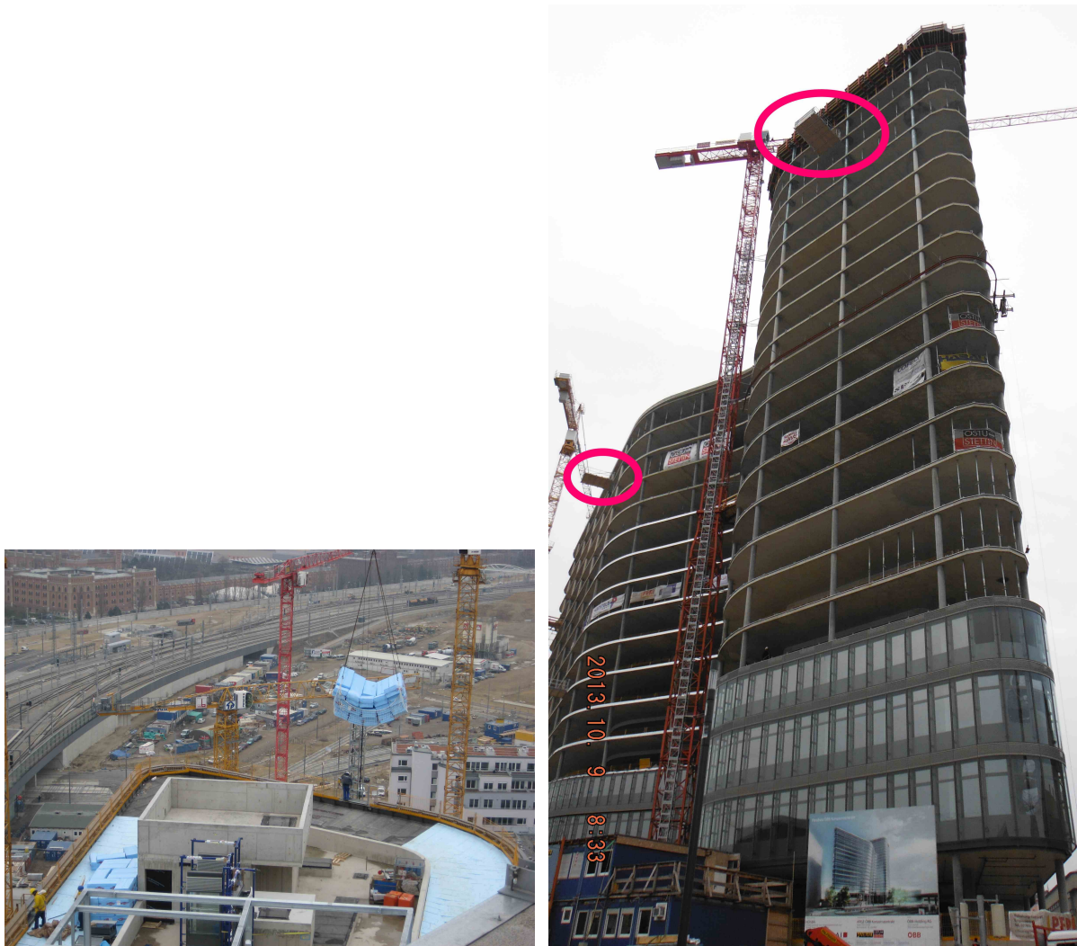
Abbildung 4.37: Materialmanipulation mit Kran K2
