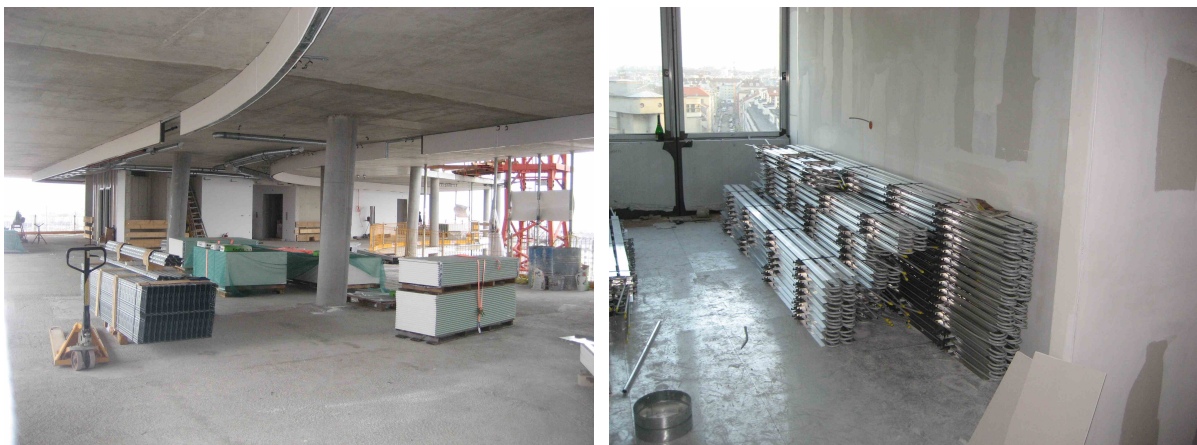
Abbildung 4.26: Materiallagerung diverser Bauprodukte 1
