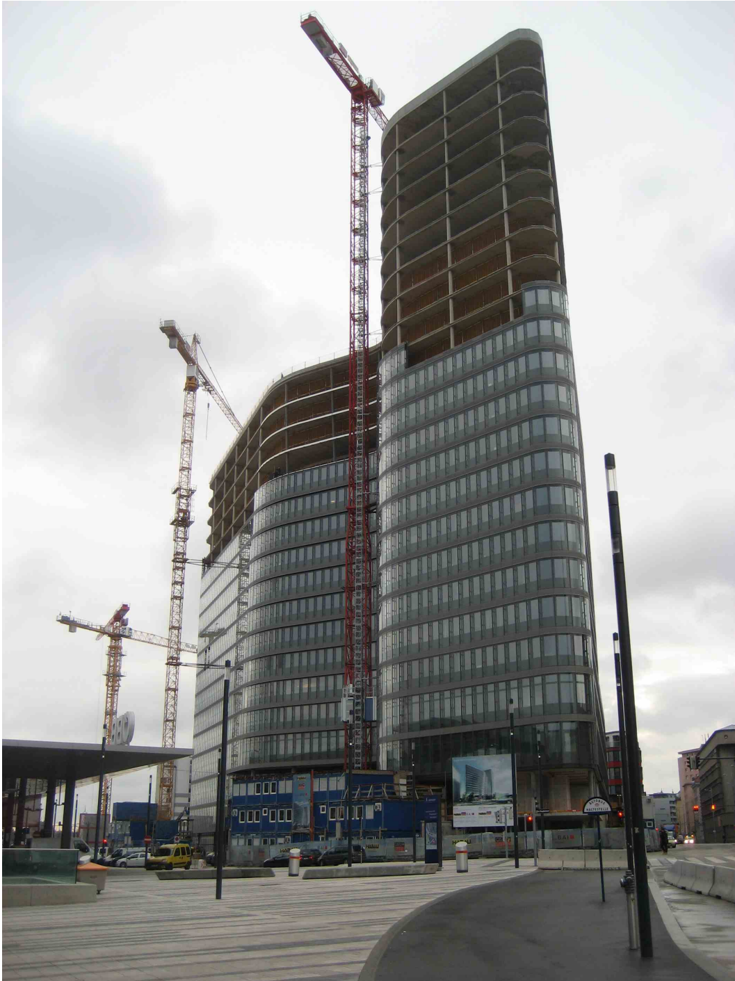
Abbildung 3.3: Projektfortschritt ÖBB-Konzernzentrale, Stand: 22.01.2014
