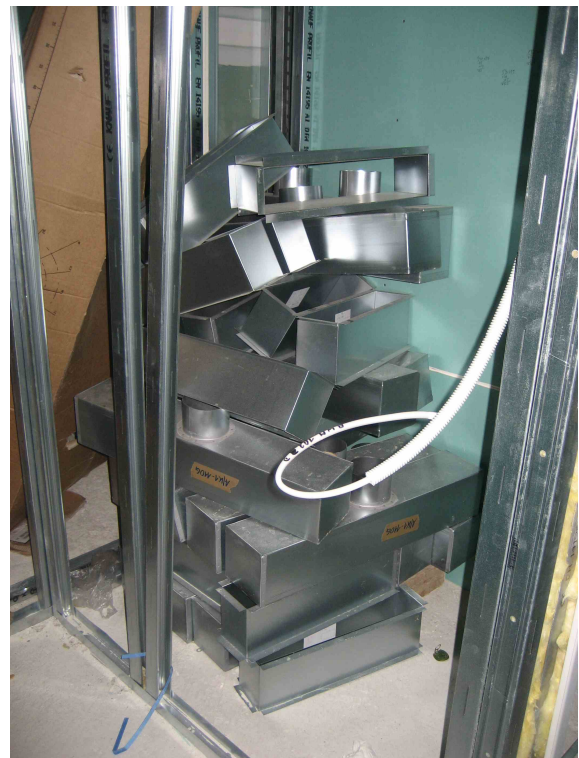
Abbildung 4.21: Materiallagerung von HKLS-Lüftungsmaterialien
