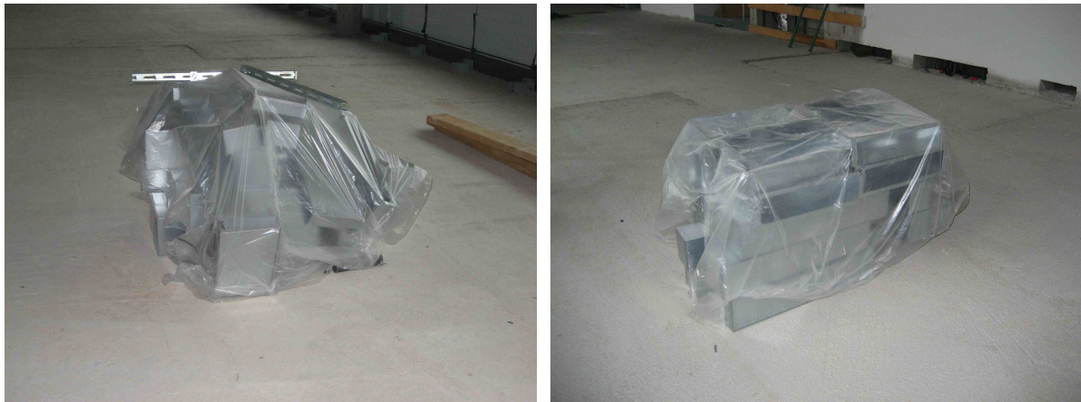
Abbildung 4.22: Verbesserte Materiallagerung von HKLS-Lüftungsmaterialien
