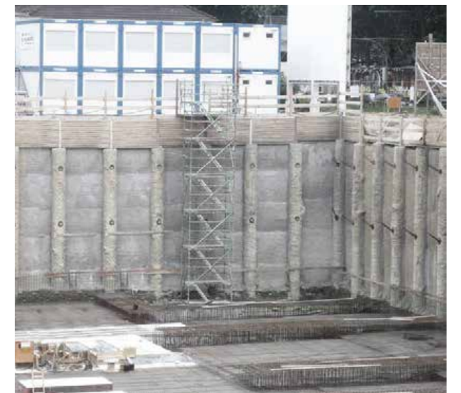
Abb. 19 Baugrube mit aufgelöster Bohrpfahlwand
