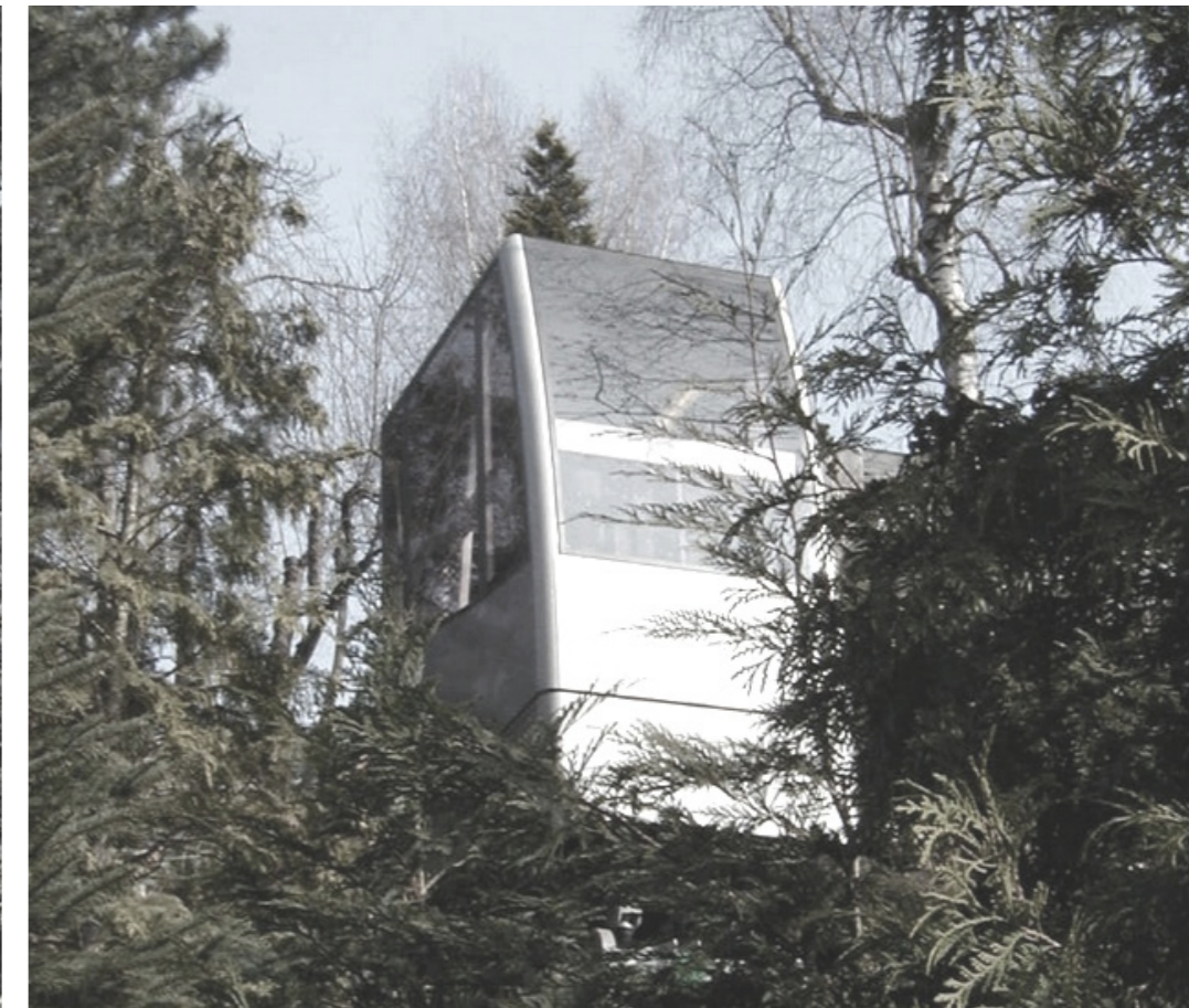
Abb.16 Schrägaufzug Privatvilla, Wien
