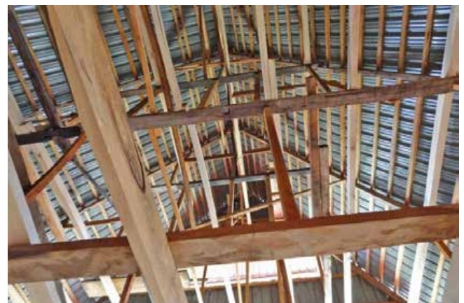
fig. 84: roof construction of the Omo Sebua "shiae 095"
