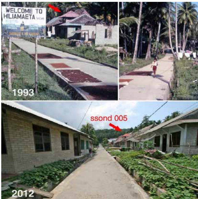
fig. 42: foundation of Sondregeasi
