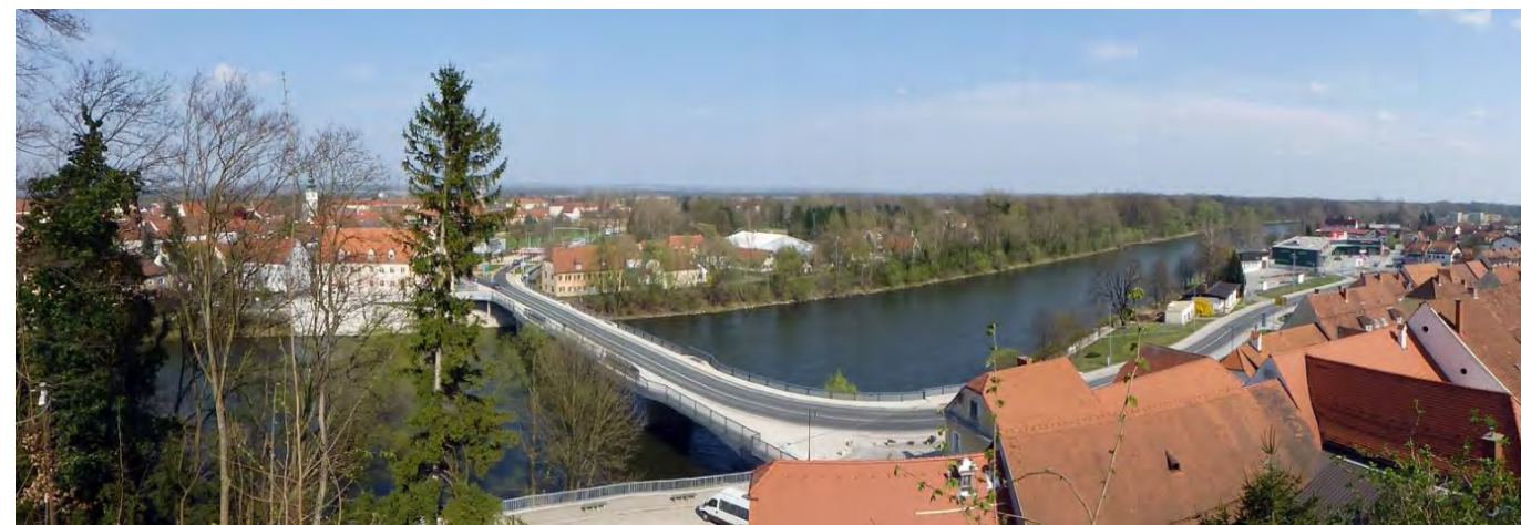
Abb. 07 Blick vom Schloßberg auf die Murbrücke
