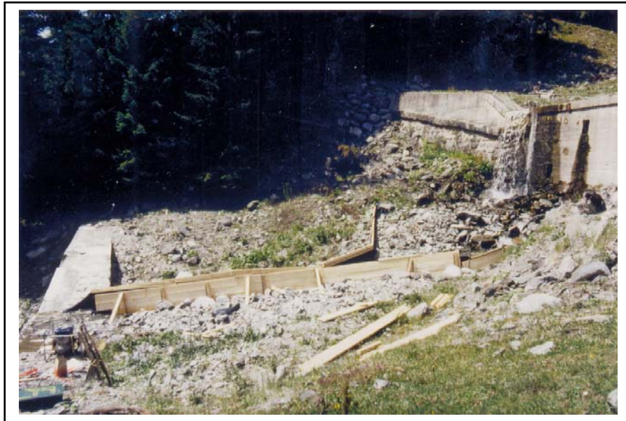
Foto 25: Messrinne am Neuhausengraben im Zustand unmittelbar nach Fertigstellung im Juli 1992.
