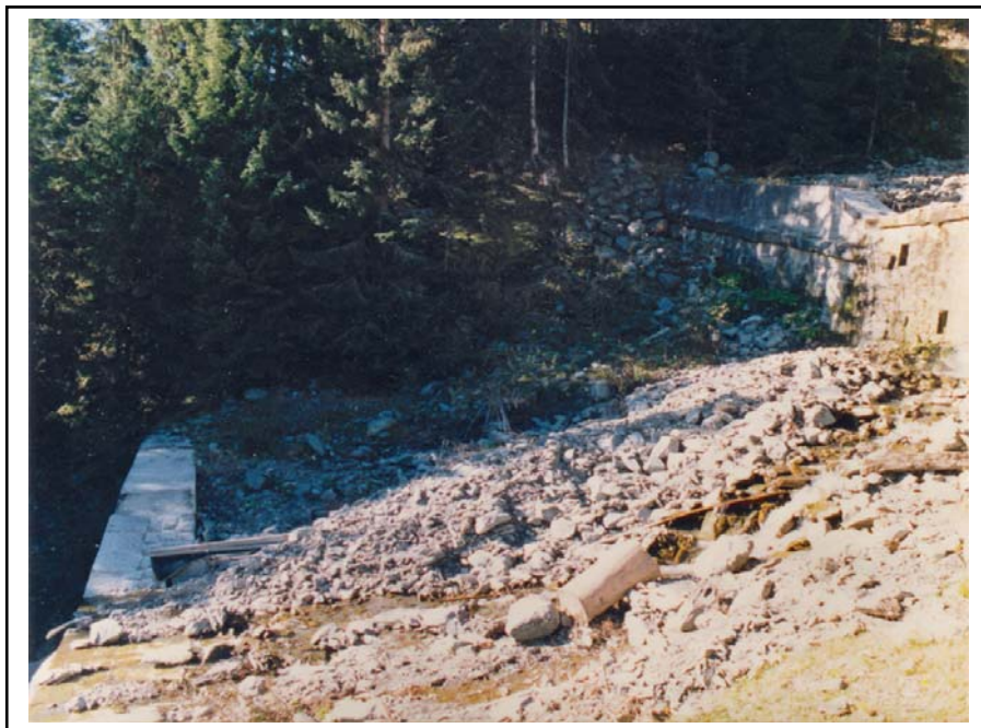
Foto 26: Mit Geschiebe verschüttete Messrinne am Neuhausengraben nach den Ereignissen am 10. Juli 1995 bzw. 27. Juli 1995.
