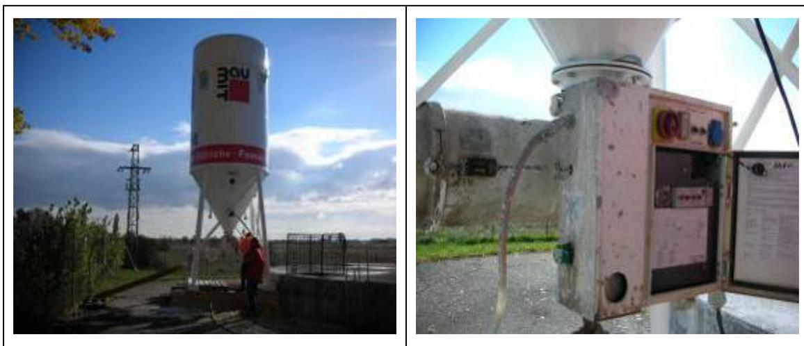
**Abbildung 44:** Kalksilo (links) und Steueranlage für die Kalkmilchvorbereitung (rechts) beim HPW, Illmitz
