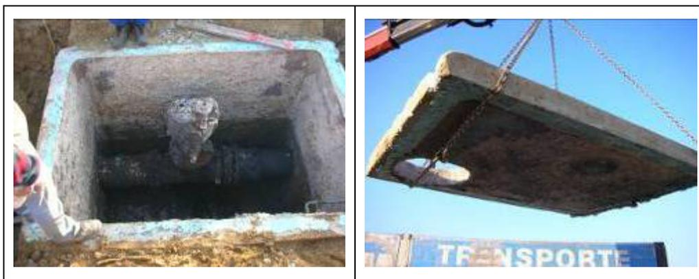
**Abbildung 30:** Korrosionsschäden beim Leitungshochpunkt des Druckleitung Rusterberg (Matsché und Saracevic, 2007 b)
