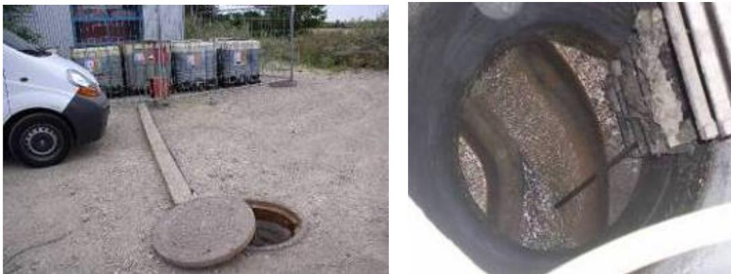
**Abbildung 58:** Dosierstelle Freispiegelleitung Guntramsdorf
