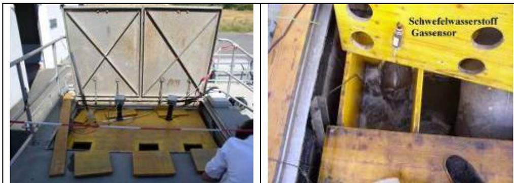
**Abbildung 49:** Adaptierte Übernahmebauwerk bei RHV NSW (li) mit installiertem Sensor für  $\text{H}_2\text{S}_g$  Messung (re.)
