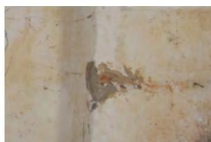
Aufgrund der beschädigten Ecke der Fensternische kann man hier ein Stück eines Ziegels erkennen. Der Putz scheint etwa 3cm dick zu sein.
