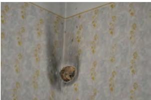
Ehemaliger Kaminanschluss. Darüber ist die Wand verrußt. Er ist innerhalb der Wand geführt und mündet in den im Dachstuhl sichtbaren Kamin.
