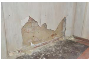
Aufgrund von Schäden ist der Putz bis zum Mauerwerk beschädigt.
