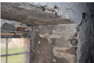
Fensterdetail zum Innenhof. Fixverglasung, außenbündig. Derzeit zusätzlich mit Folie verschlossen. Konstruktion gleicht den Fenstern von Raum 01 und Raum 02
