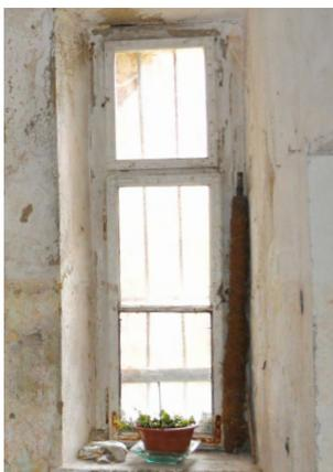
Das schmale Fenster besitzt eine einseitig schräge Leibung und einen schrägen Sturz. Es ist halb in die normal dazu stehende Außenmauer versetzt. Im Gegensatz zu den anderen Fenstern hat es einen einfachen Flügel und keinen Kasten. Fensterflügel, sowie Sprossen, Kämpfer und Rahmen sind außen wie innen weiß beschichtet. Die Beschläge sind stark verrostet. Das Fenster scheint nicht mehr funktionstüchtig.
