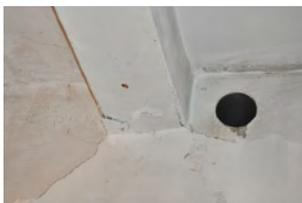
Im Bereich des Unterzuges und der Ofenstütze erkennt man Rissbildungen. An der Unterkante des UZ löst sich Putz und Putzträger ab.
