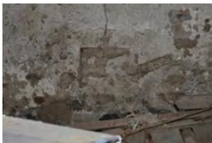
Desolater Putz mit scharfkantigen Putzänderungen, womöglich früher benötigte Öffnungen für Konstruktionen der Mühle etc.
