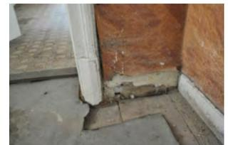
Starke Risse zum Dachraum, eventuell ist das Dach darüber undicht.
