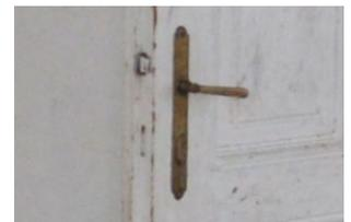
Die nach Osten orientierte Wand (03) ist eine der dünnsten in der Mühle. Die weiß lackierte Kassetentüre ist mit einer Umfassungszarge aus Holz mit der Maueröffnung verbunden.
