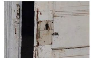
Die nach Osten orientierte Innenwand (03) hat nur geringfügige Schimmelschäden. Das Türblatt selbst weist starke Gebrauchsspuren auf bzw. hat es einen deutlichen Gelbstich. Vermutlich wurde das Türblatt ausgetauscht bzw. gespiegelt, da auf beiden Seiten der Zarge Bänder zu erkennen sind.
