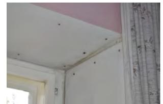
Die Hartfaserplatten wurden durch Feuchtigkeit ebenfalls beschädigt.
