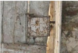
Das Kastenschloss gehört im Vergleich zu den anderen Schlössern zu den älteren. Es ist in einem schlechten Zustand, da es von Rost beschädigt ist.
