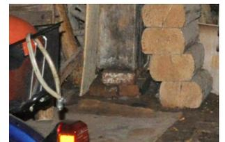
Feuchtigkeitsschäden an einem Unterzug etwa mittig des Gebäudes.
