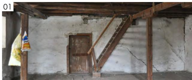
Die Westwand (01) schließt an einen weiteren kleinen Raum an. Die Löcher in der Wand, könnten darauf hindeuten, dass es einmal mehr Unterzüge in diesem Raum gab. Die Stiegen sind sehr steil und etwas wackelig.
