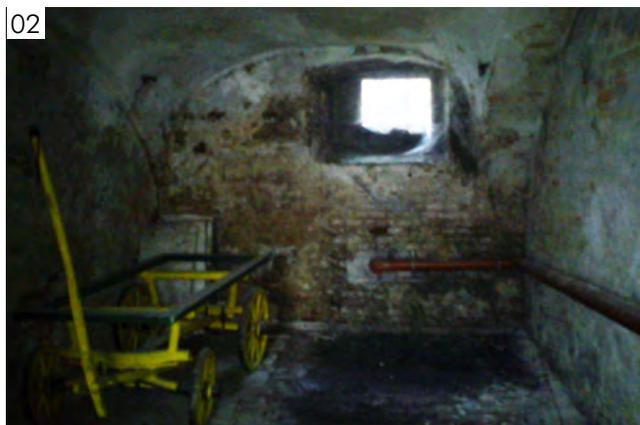
Südwand (02) ist zur Straße orientiert. Das Fenster hat eine Fixverglasung, welche durch eine waagrechte und zwei senkrechte Sprossen unterteilt ist. Es ist rechtsbündig in der schrägen Leibung positioniert.
