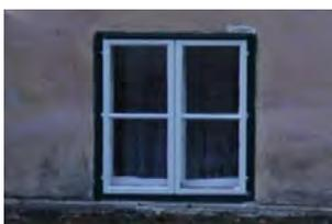
Das Fenster hat zwei Fensterflügel, die mit weißem Lack beschichtet sind. Die Glasfläche ist mit einer waagrechten Sprosse unterteilt. Der Fensterrahmen ist außen grün und innen weiß lackiert.
