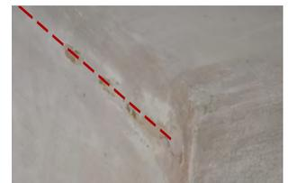
Die nordseitige Wand (04) des Badezimmers ist mit Schränken verstellt, sodass keine Bestandsaufnahme der Wand möglich war. Die sichtbare Wand weist ebenfalls Schäden aufgrund der Feuchtigkeit auf.
