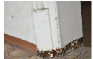
Die Ostwand (03) führt mit einem Niveausprung von 5cm in Raum 20. Hier sind leichte Risse zu erkennen.
