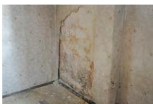
Links unter dem Fenster hat die Feuchtigkeit die Wandoberfläche stark beschädigt, Putz fällt ab und Schimmel ist die Folge.
