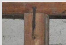
Aufgrund der hartkantigen Holzquerschnitte wird angenommen, dass die Decke des Obergeschoßes später errichtet wurde als die des Erdgeschoßes
