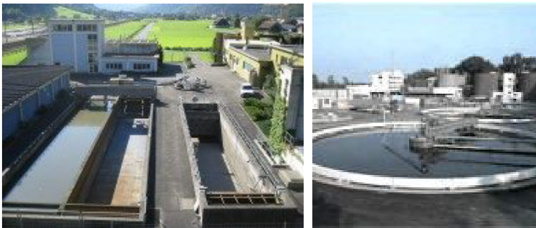
Abbildung 1: „Wasseraufbereitungsanlage VODOKANAL; St Petersburg, russische Föderation“
