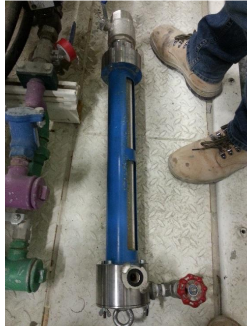
Abb. 3-11: Schaumlanze mit Glaskugeln als Störkörper - Green Line Underground Doha
