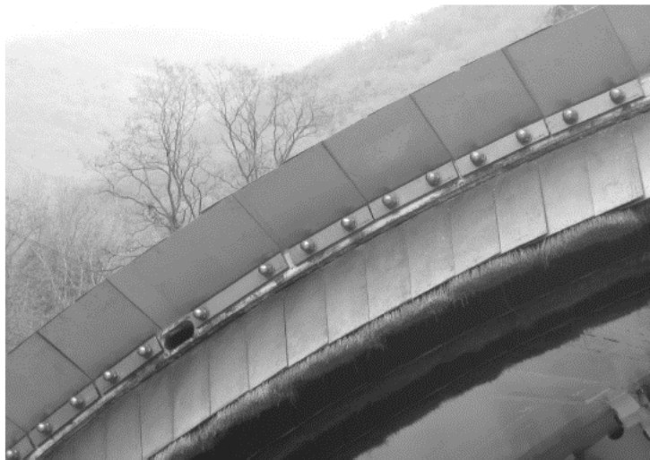
Abb. 6-5: äußere Schildschwanzdichtung 107
