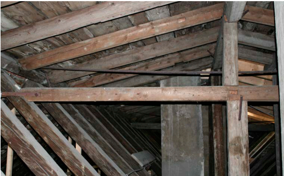
Abbildung 94 Blick auf die Pfettendachkonstruktion des südöstlichen Dachwerks
