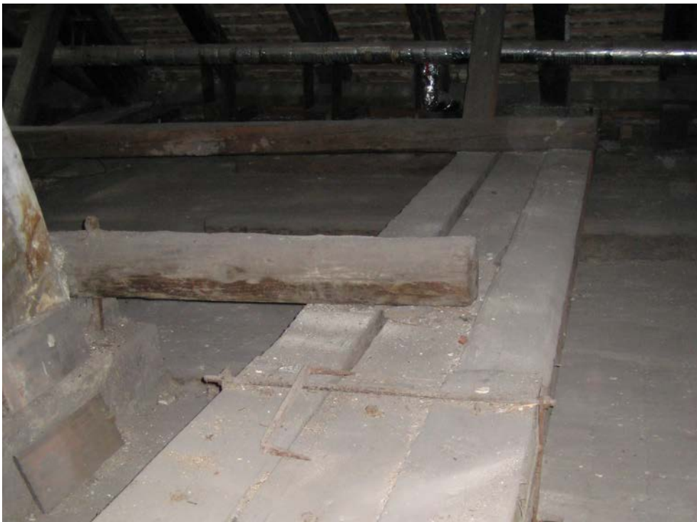
Abbildung 88 Blick auf die Bundtramverstärkungen von Gespärre 3
