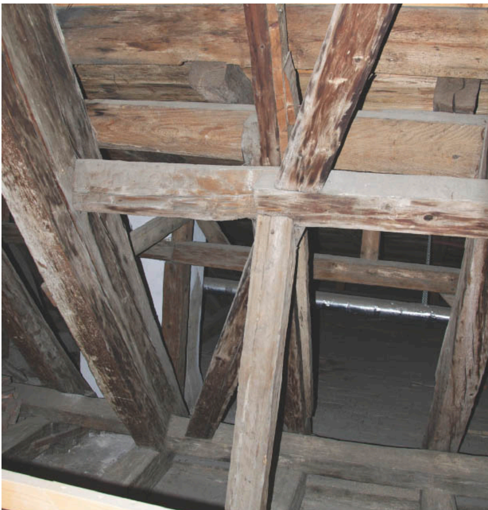
Abbildung 117 Blick auf Brustriegel zwischen den Gespärren 2 und 3
