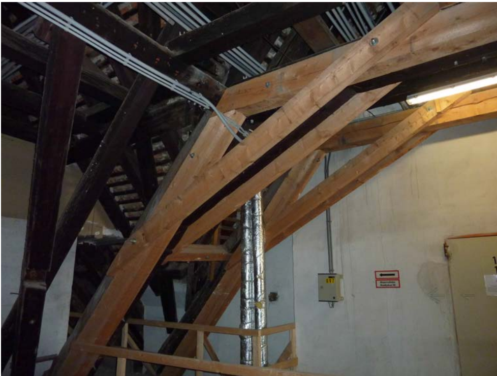
Abbildung 25 Blick auf erneuerte Stuhlkonstruktionen im NW-Dachwerk
