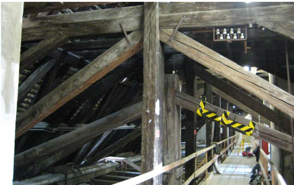
Abbildung 29 Blick auf hinzugefügte Hängekonstruktion aus dem 19. Jahrhundert
