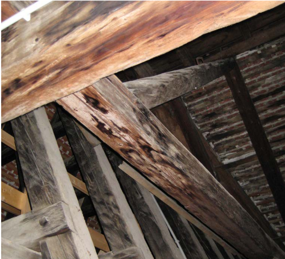
Abbildung 95 Blick auf Anbindung Dachwerk Südosttrakt und Dachwerk Hofburgkapelle
