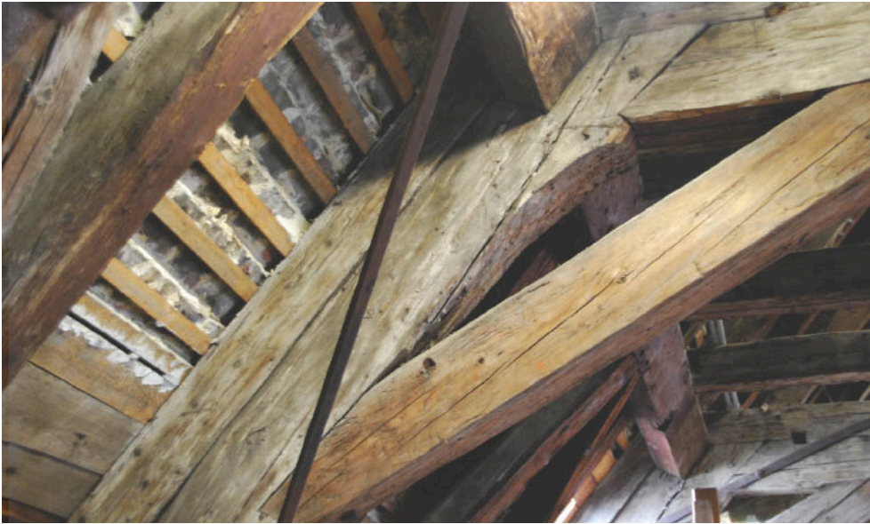
Abbildung 119 Blick auf Stuhlsäule mit Abrundung am Übergang zum Spannriegel
