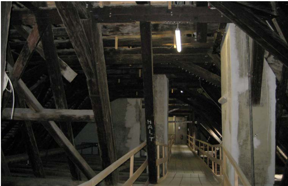
Abbildung 23 Blick auf Abwalmung des NW-Dachwerks in Richtung Nordosten
