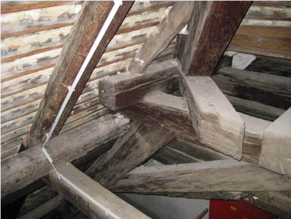
Abbildung 56 Blick auf Ecke der erneuerten Dachkonstruktion im Süden des nordöstlichen Dachwerks
