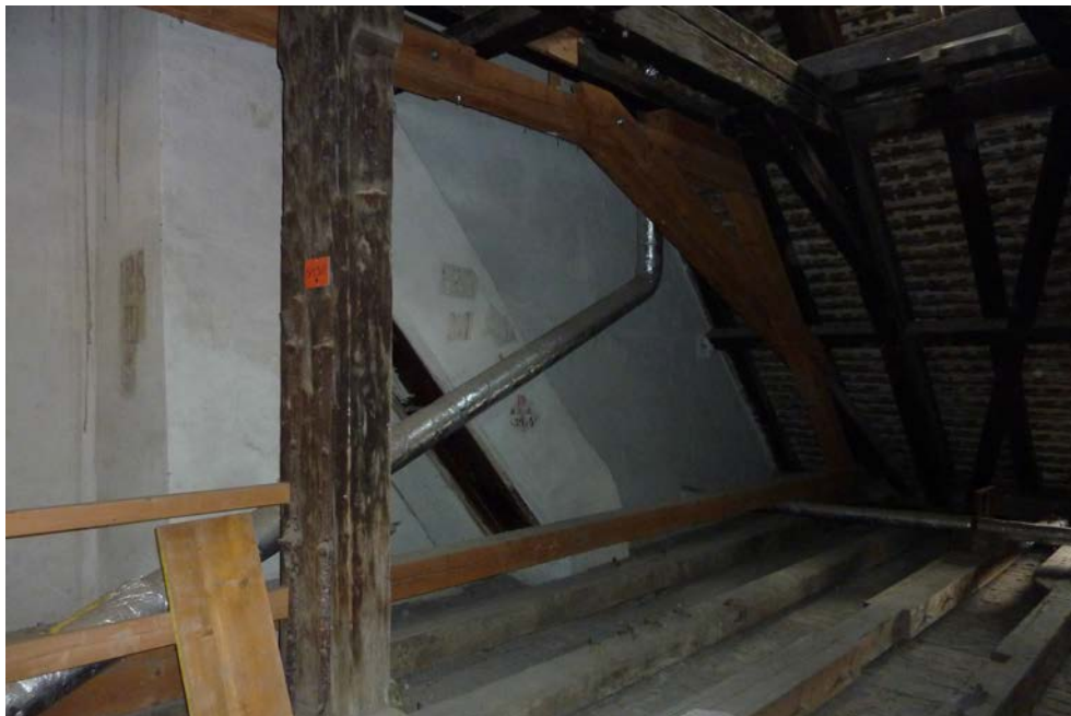
Abbildung 55 Blick auf erneuerte Stuhlkonstruktion in Gespärre 4.3
