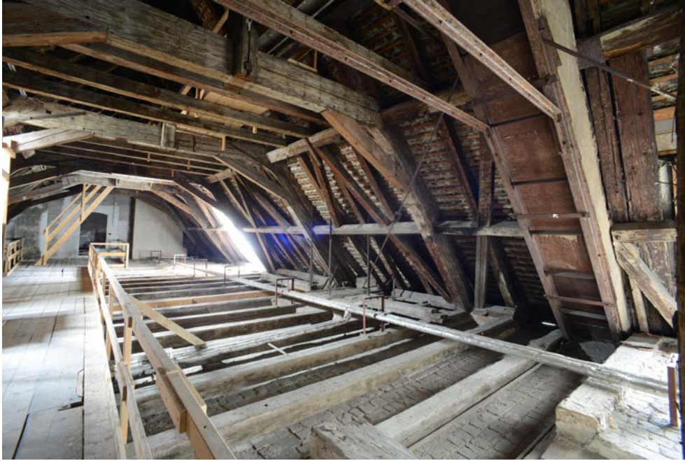
Abbildung 122 Blick in Richtung Süden auf den umgebauten Teil des südwestlichen Dachwerks
