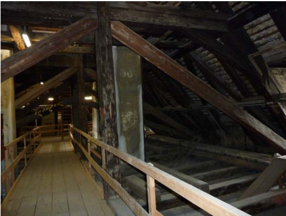
Abbildung 24 Blick Richtung Westen auf Sprengwerke des NW-Dachwerks
