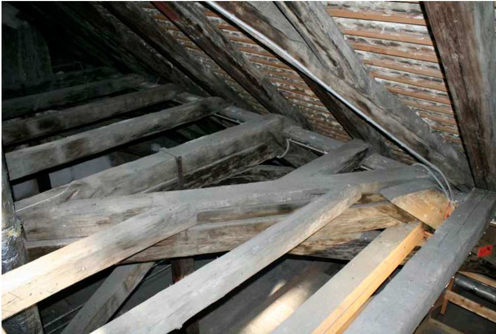
Abbildung 92 Blick auf diagonal angeordnete Stuhlsäule
