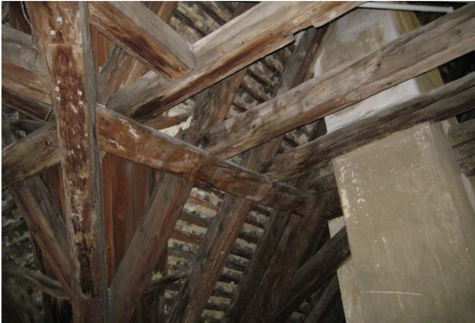
Abbildung 28 Blick auf die Gespärre 13.1 bis 13.3
