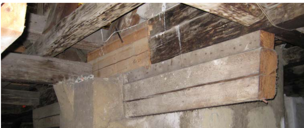
Abbildung 89 Blick auf Kehlbalken und Spannriegel im Gespärre 1
