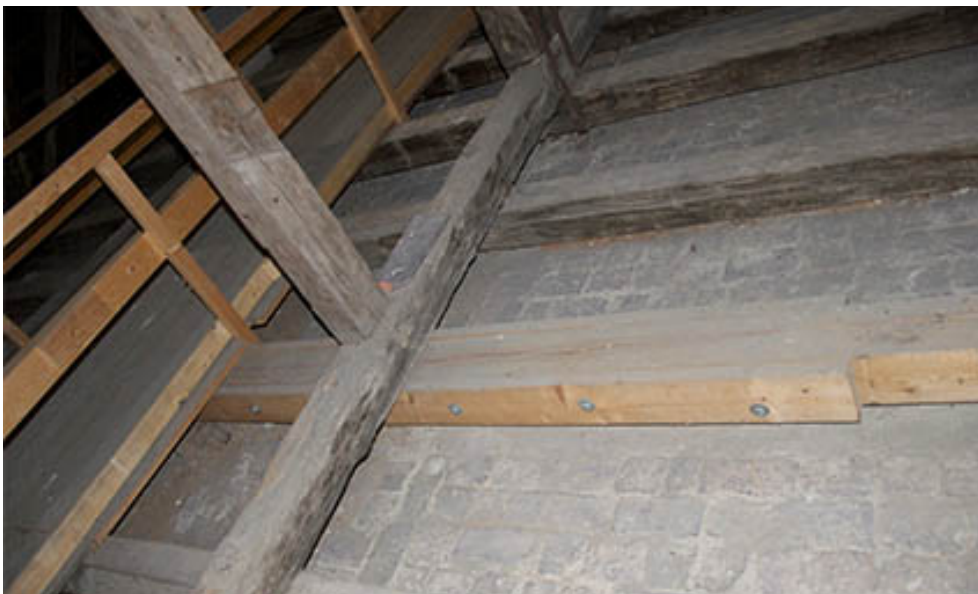
Abbildung 118 Blick auf neuen Bundtrame in Gespärre 1.3
