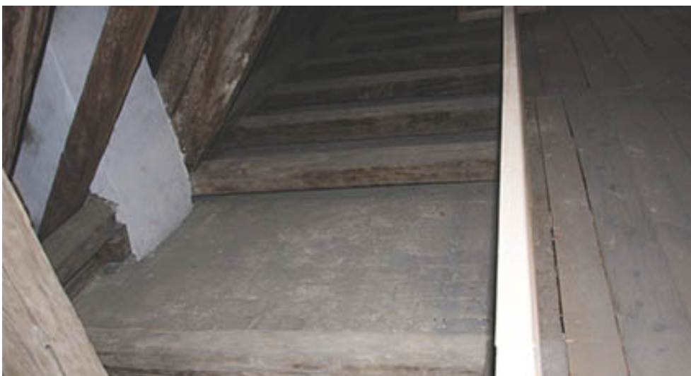
Abbildung 115 Blick auf Kaminschacht zwischen den Gespärren 2.3 und 3
