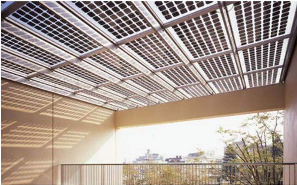
Abbildung 29: Semitransparente PV-Module (solar-construction)
