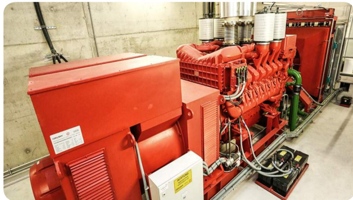
Abb. 112. Notstromgenerator des DC Tower (inwien.at)
