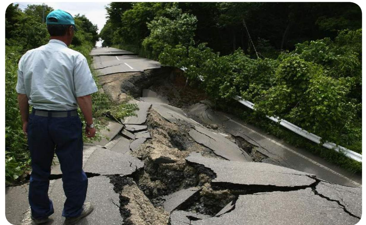
Abb. 34: Infolge eines Erdbebens zerstörte Straße (www.tagesspiegel.de)
