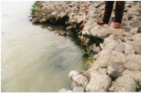
Bild 3.4.18. Schadenklasse 3-SK3 [56]
