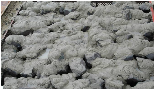
Bild 3.3.9. Nicht sachgerecht hergestelltes teilvergossenes Deckwerk mit zu steifem Vergussstoff (70 l/m 2 CP 90/250 , Einbau von Hand) [51]
