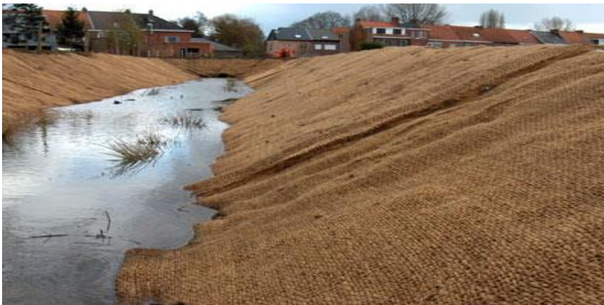
Bild 3.2.6. Anpressen der Matte mit schwerem Geräte [44]
