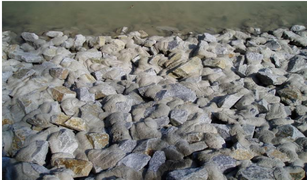
Bild 3.3.8. Sachgerecht hergestelltes teilvergossenes Deckwerk (30 l/m 2 , CP 90/250 , Einbau von Hand) [51]
