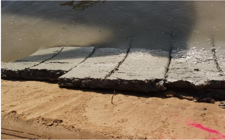
Bild 3.3.17. Fertig verlegte Tonbahnen [68]
