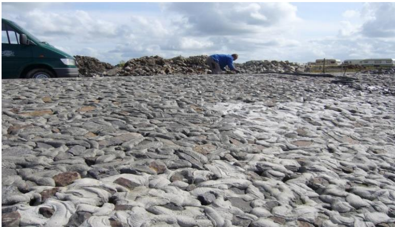
Bild 3.3.19. Verklammertes Uferdeckwerk aus Wasserbausteinen, von Hand gesetzt und fest verpackt. [70]
