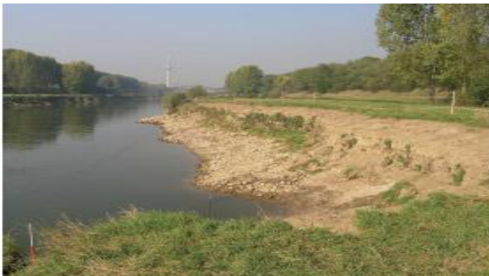
Bild 2.4.2. Starke Ufererosionen am Neckar bei Mannheim [41]
