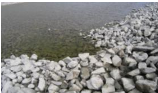
Bild 3.4.4. Schadenklasse 2-SK2 [56]
