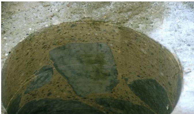
Bild 3.3.11. Blick in eine Großbohrung in einem vollvergossenen Deckwerk [51]
