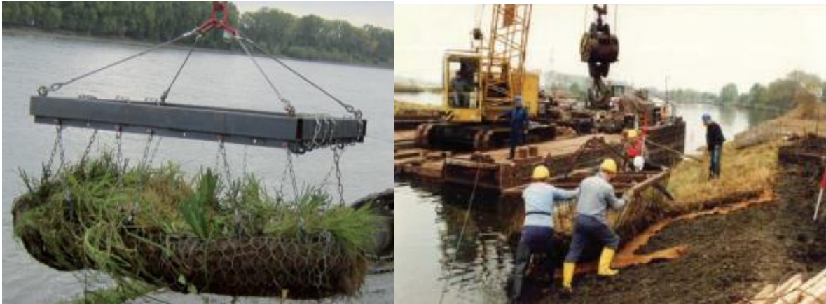
Bild. 5.4. Röhrichtgabionen – vorgezogene Einzelelemente [42];[96]
