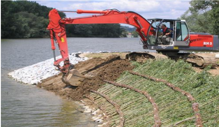
Bild 5.2. Weideneinbau als Böschungssicherung [92]
