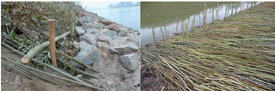
Bild 5.1. Weidenspreitlagen, in die Steinschuttung einbindend [42]
