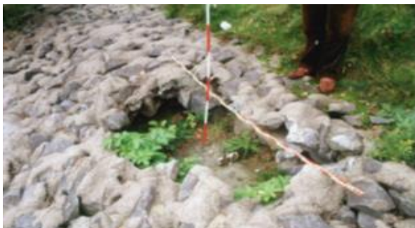
Bild 3.4.8. Schadenklasse 3-SK3 [56]
