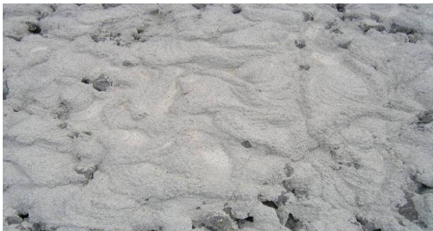
Bild 3.3.9. Nicht sachgerecht hergestelltes teilvergossenes Deckwerk mit zu steifem Vergussstoff (70 l/m 2 CP 90/250 , Einbau von Hand) [51]
