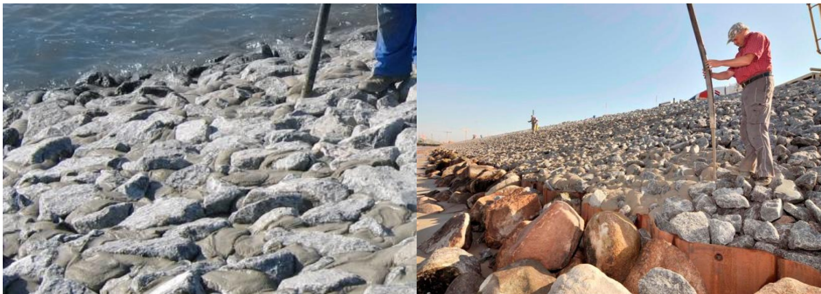
Bild 3.3.7. Einsatz des Vergussmaterials im Deckwerksbau[40];[51]
