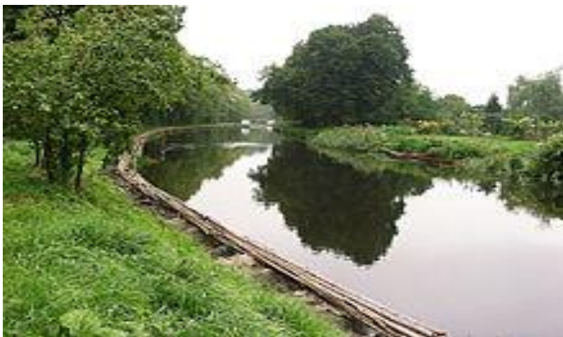
Bild 5.8 Mit Faschienen befestigtes Ufer des Kanals in Templin [95]
