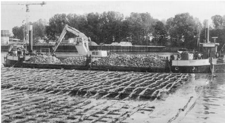
Bild 4.2.24 Geotextil mit Faschinenrost /Sinkstück/[77]
