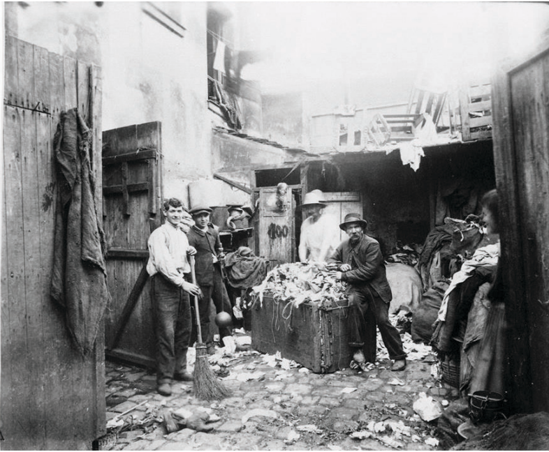
Photo einer Straße in Paris vor dem Umbau Haussmanns
