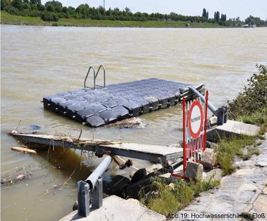
Abb.19: Hochwasserschäden Floß
