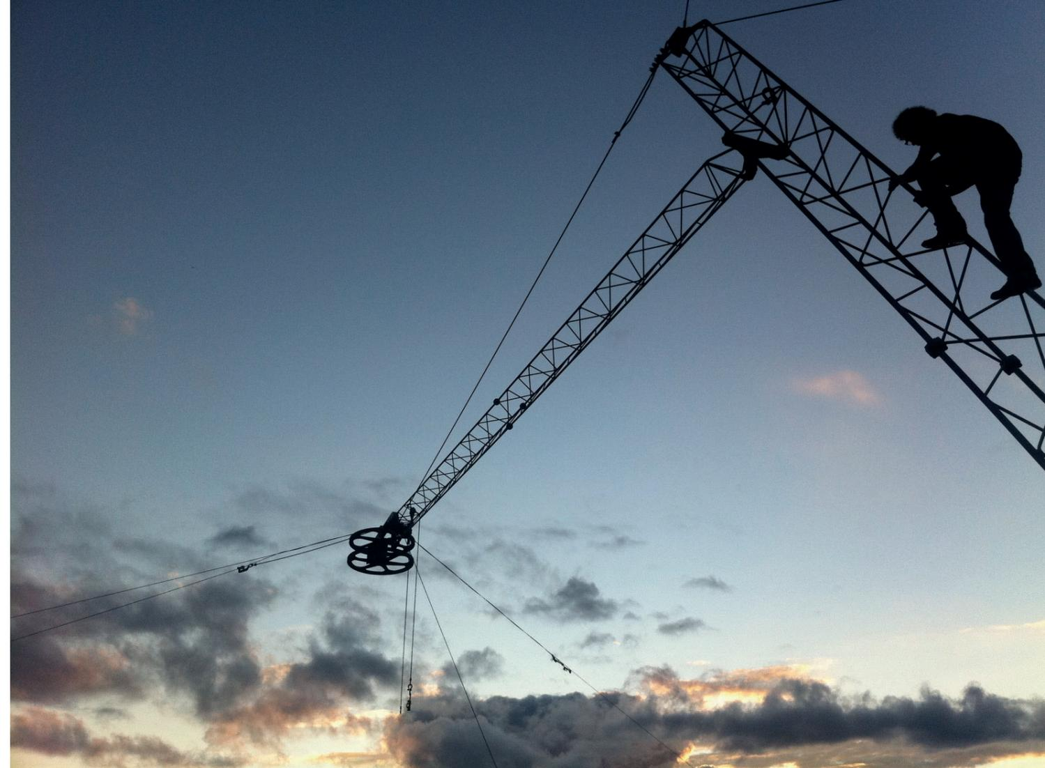
Abb. 14: Liftmasten mit Ausleger und Umlenkrolle Einbau des Umlaufseils am jettlake Feldkirchen (OÖ)
