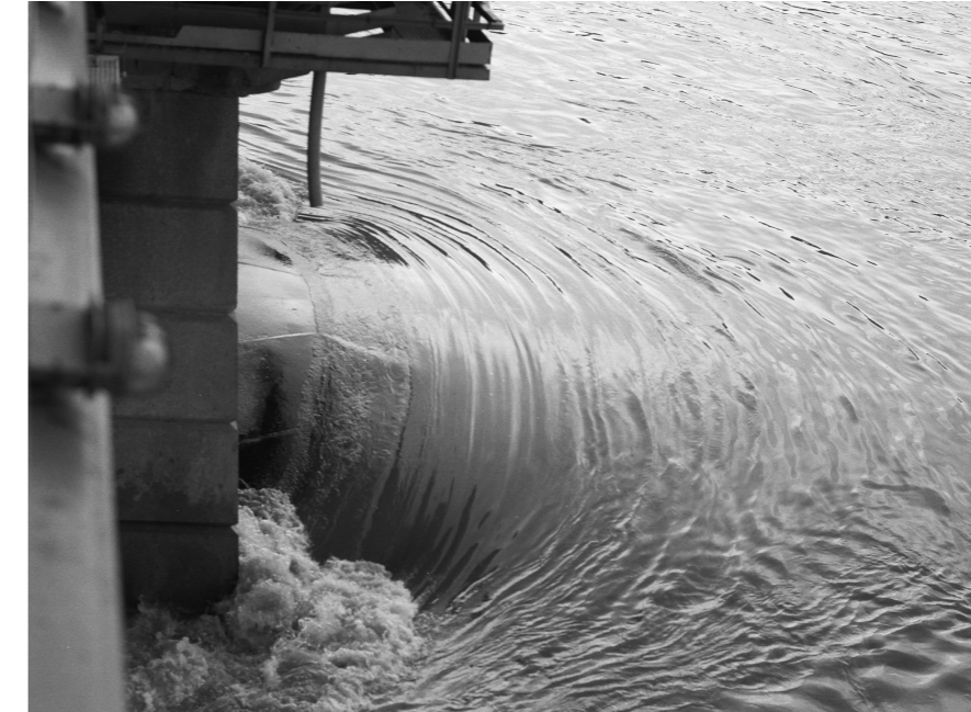
Abb. 19: Hochw. 2006; Kettenbrücke, Brückenpfeiler; Privatfoto
