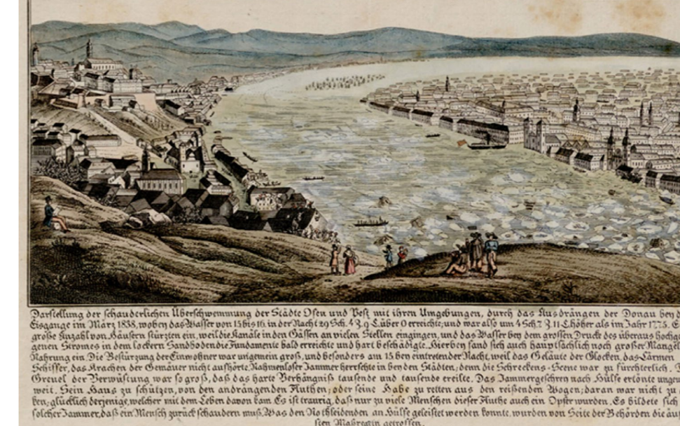
Abb. 17: Das Hochwasser von 1838; Sicht vom Gellertberg aus.
