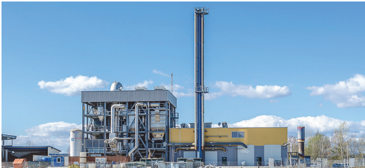
Abbildung 11: Totalansicht der Biomassevergasungsanlage in Oberwart, Burgenland [81]
