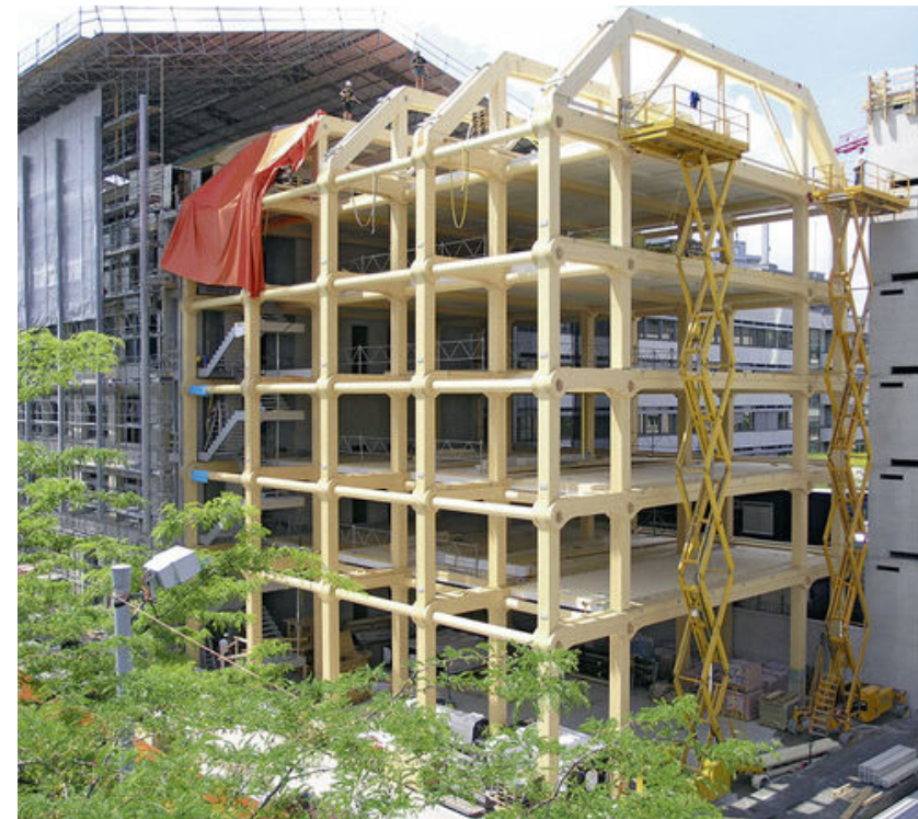
Abb15.: Holzskelettbauweise, Shigeru Ban Architects
