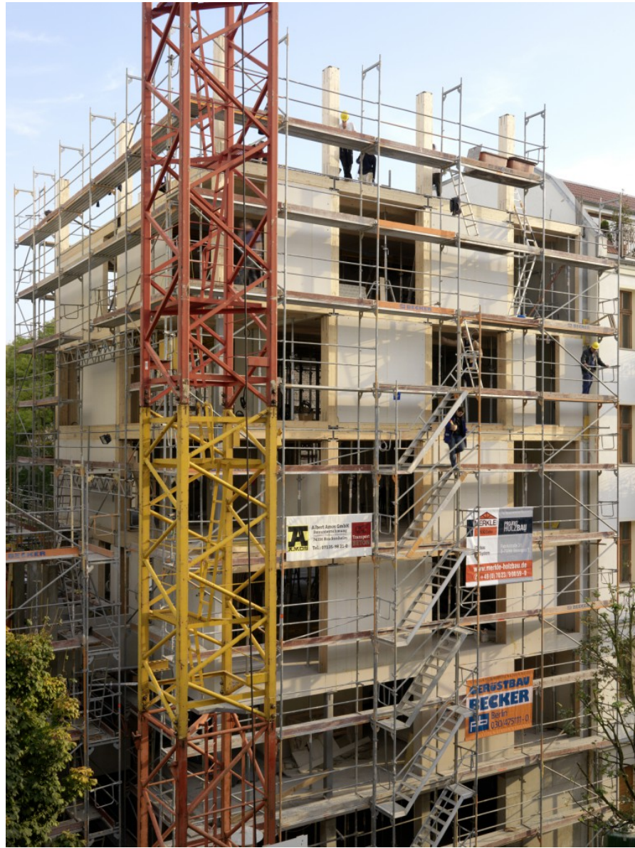
Abb.:21 E3 Fassadenmontage
