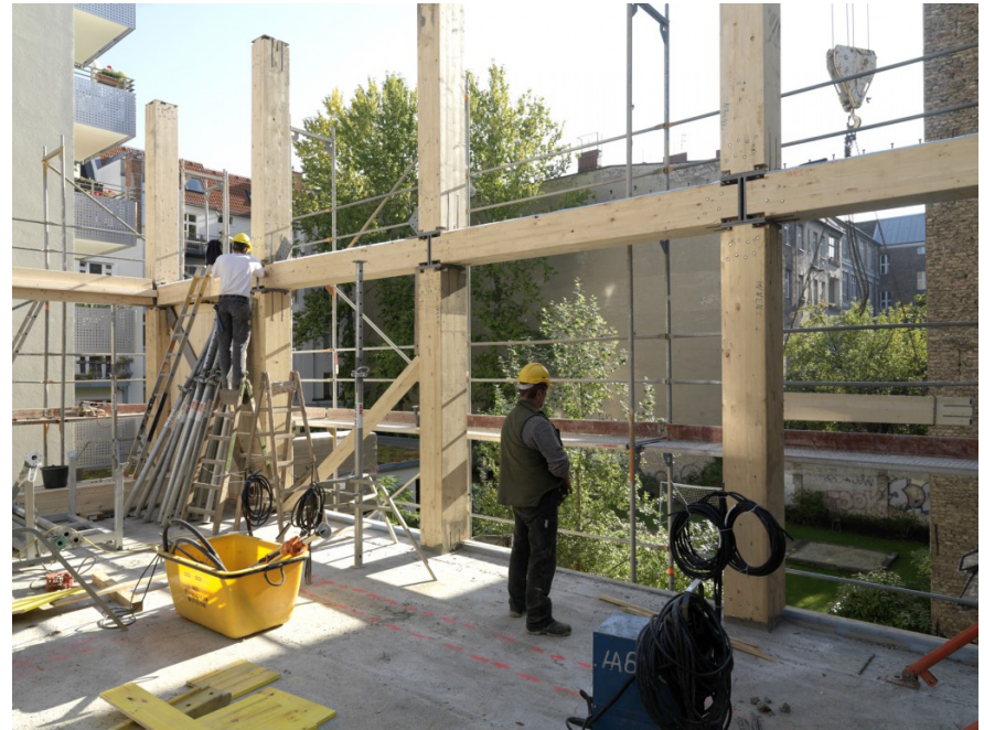
Abb.:23 E3 Skelettftragwerk
