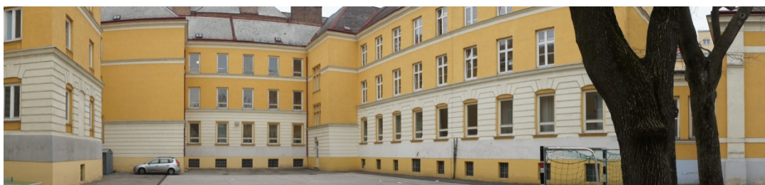
Abbildung 78: Fassade der Franz Jonas Europaschule hofseitig
