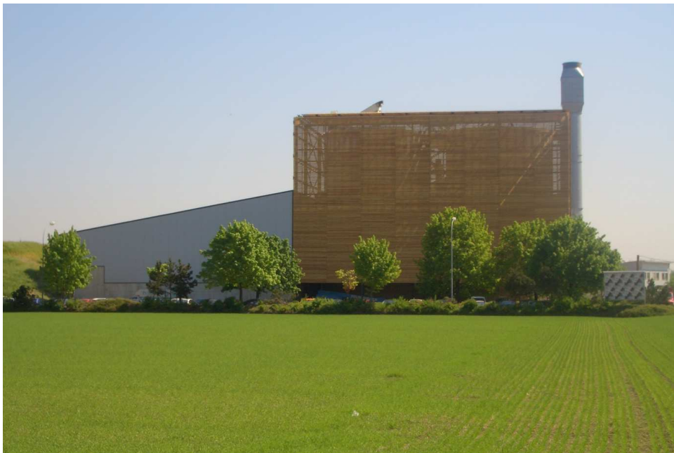
Abbildung 28: Außenansicht HKW Klagenfurt [10]
