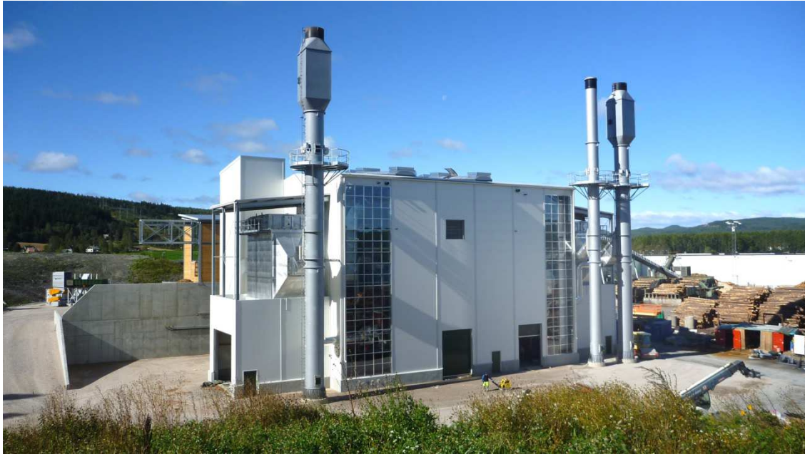
Abbildung 37: Außenansicht SCA Timber Bollstabruk [13]
