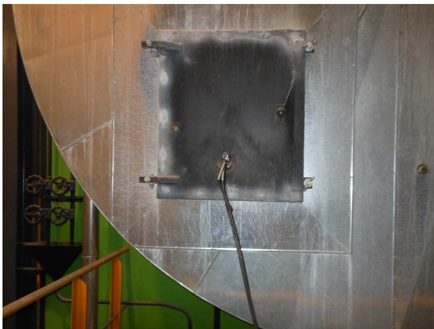
Abbildung 30: Abgas-Entnahmesonde im HKW Klagenfurt [11]
