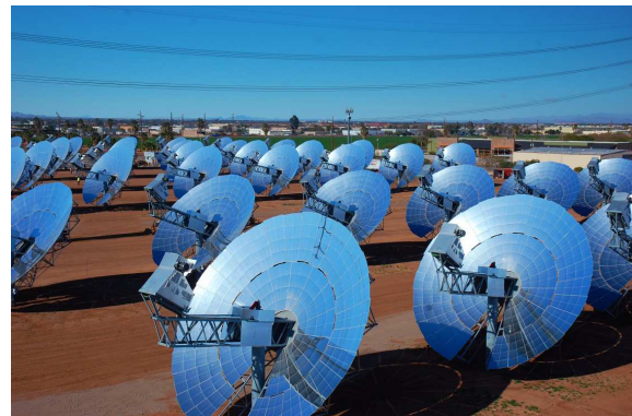
Anhang 4: Parabolic Dish Kollektor mit Stirling Motor im Kollektorfeld 278
