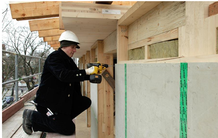
Abb. 25: Montage einer Holzleichtbetonplatte im Fassadenbereich. © Siniat GmbH
