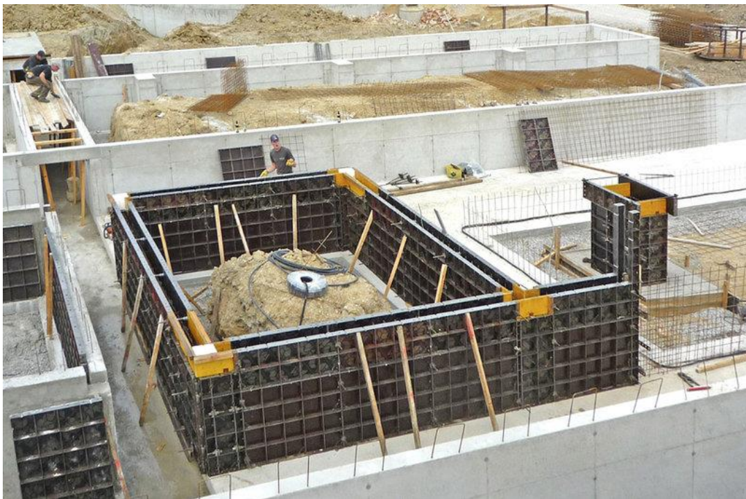
Abb. 12: WOLF Schalungssystem für Ortbeton
