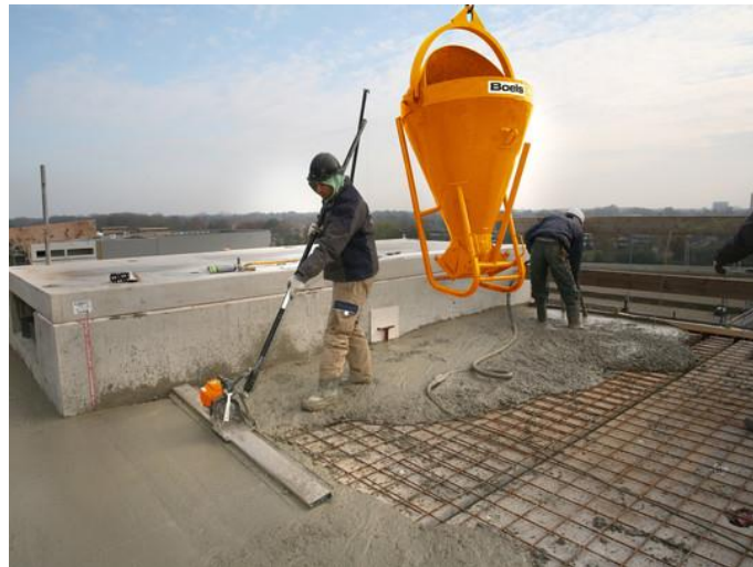
Abb. 11: Einbringen des Betons mittels Betonfüllkübel. © Boels
