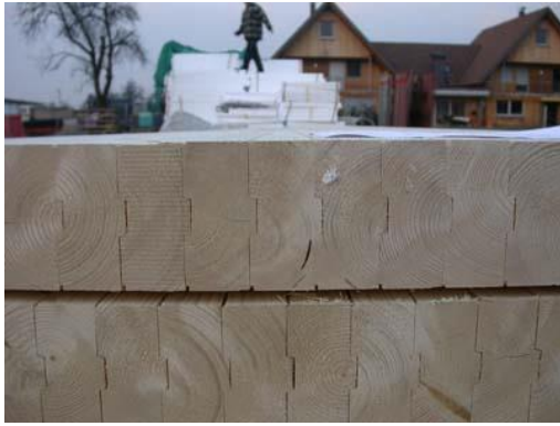
Abb. 9: Brettstapelholzdecke, Schnitt
