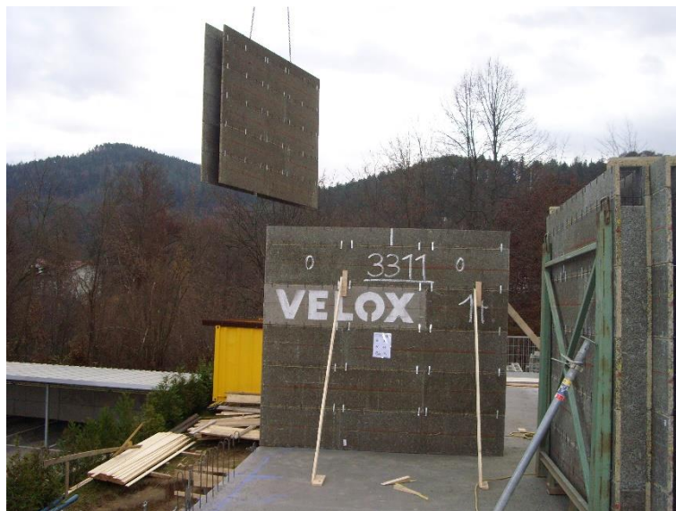
Abb. 31: Montage Velox Wandmodule © Fa. VELOX Werk GesmbH
