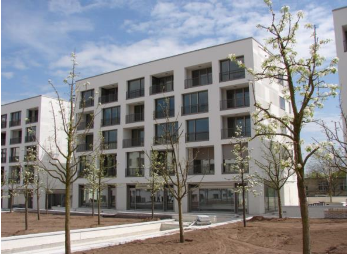
Abb. 34: Referenzgebäude „Think K“, Mittelhaus © Ed Züblin AG (05/2013)
