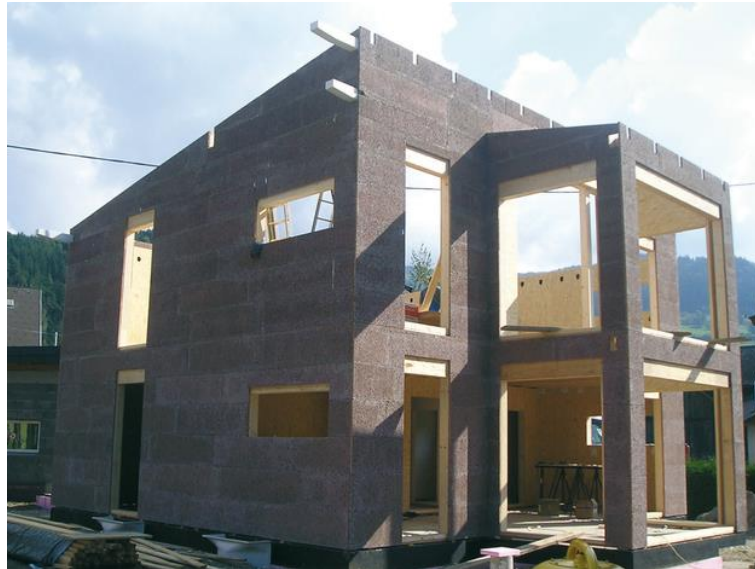
Abb. 32: Verkleidung bei Holzriegel-Konstruktion © Fa. VELOX Werk GesmbH
