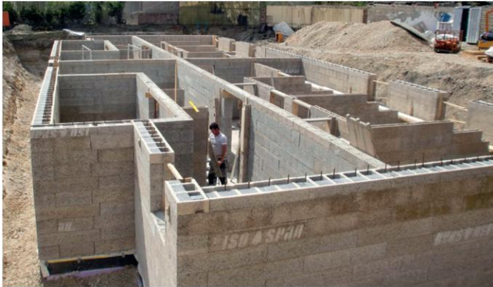
Abb. 18: Baustellenbild vom Bau mit Holzleichtbetonsteinen. © Isospan Baustoffwerk GmbH
