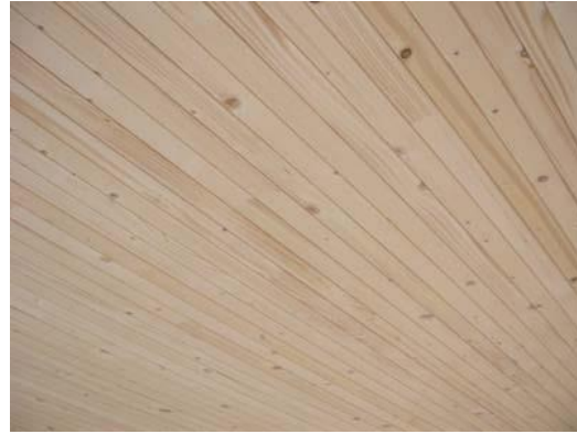
Brettstapelholzdecke, Unteransicht
