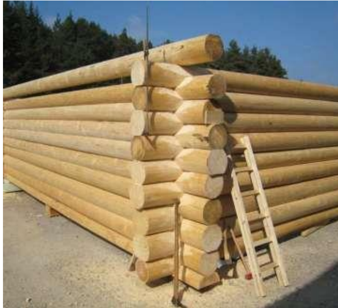
Abb. 7: Blockhausbau, Kraftschlüssiger Verbund durch Verkämmung
