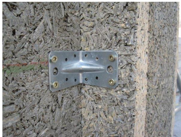
Abb. 17: Fixierung im Eckbereich oder bei Wandanschlüssen. © Fa. Velox Werk GmbH
