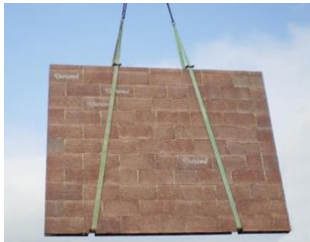
Abb. 19: Hohlwandmodul, aus Einzelsteinen vorgefertigt © Durisol-Leier GesmbH
