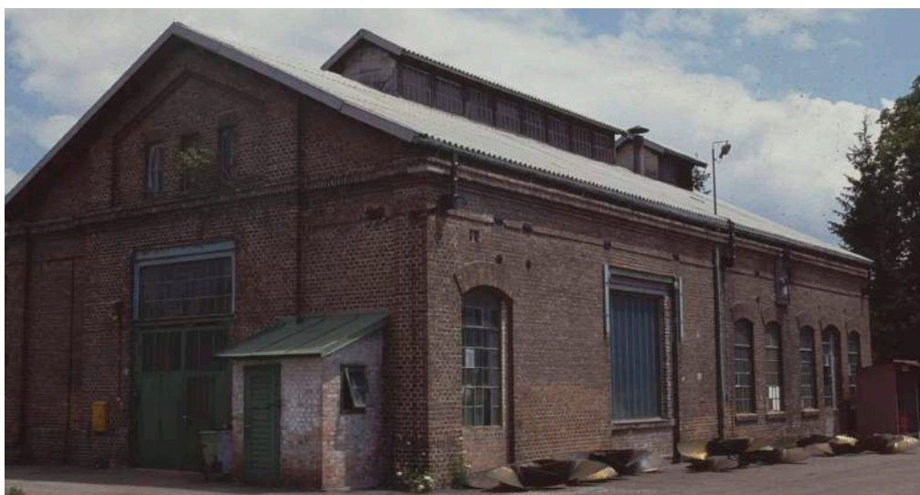
Abbildung 59: Von Stadler dokumentierter Zustand im Jahr 1991
