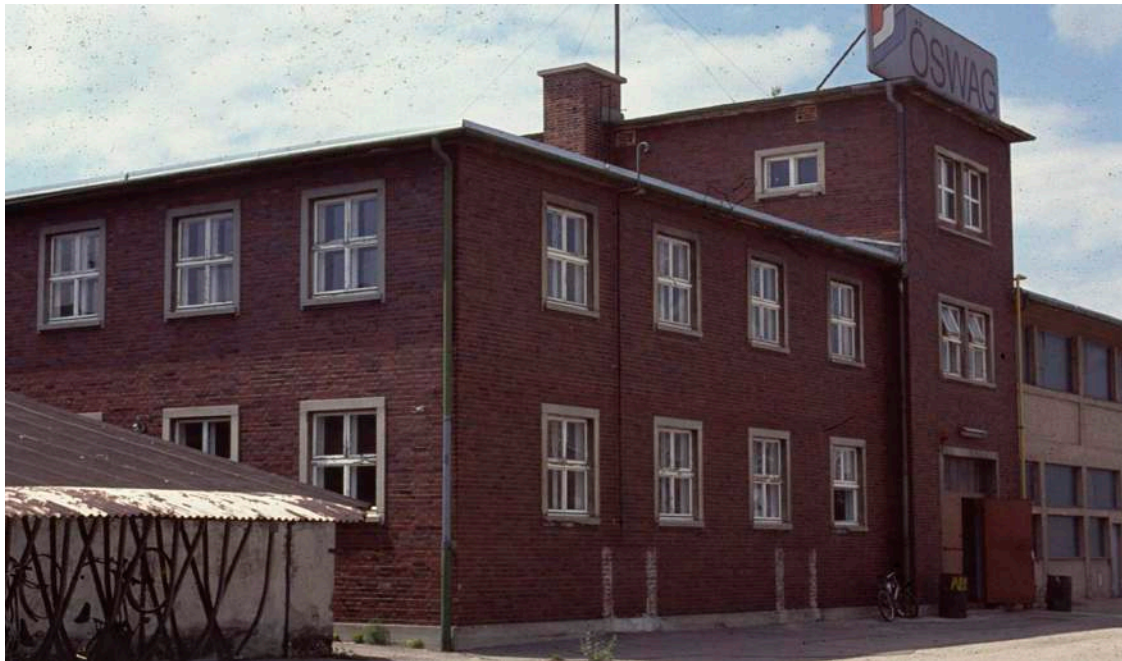
Abbildung 105: Objekt 68 aus der Fotodokumentation von Stadler; Zustand 1991
