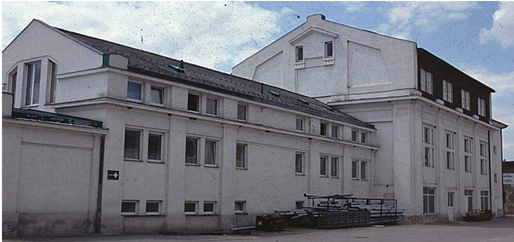
Abbildung 119: Stadler dokumentierte die ehemalige Dampfkraftanlage noch 1991
