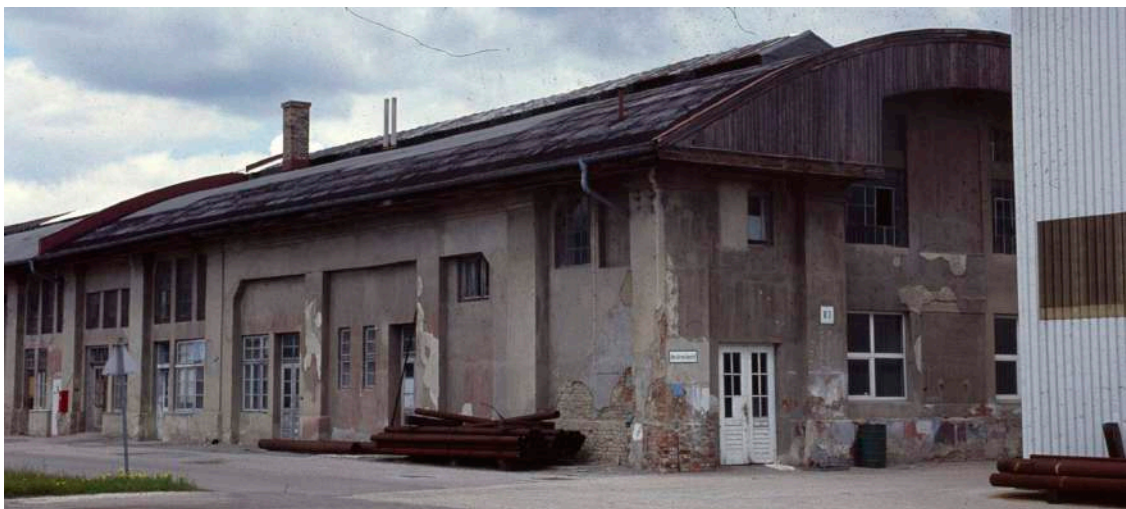
Abbildung 137: Südansicht von Objekt 83 im Jahr 1991; dokumentiert von Gerhard Stadler
