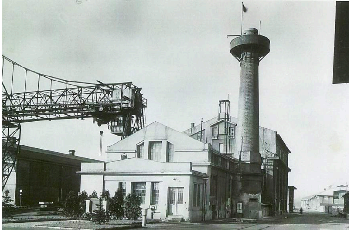
Abbildung 118: Auf einem Foto aus dem Jahr 1955 ist der markante Schornstein mit dem aufgesetzten Wasserhochbehälter noch existent
