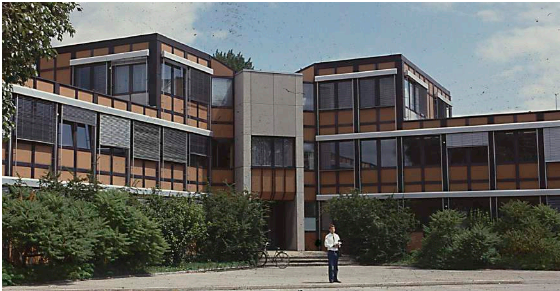
Abbildung 8: Stadler dokumentierte Objekt 205 1991 von der Innenseite der Werft
