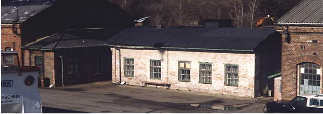
Abbildung 67: Reinhard Schröpfer dokumentierte den Zustand des Gebäudes am 4.3.2000
