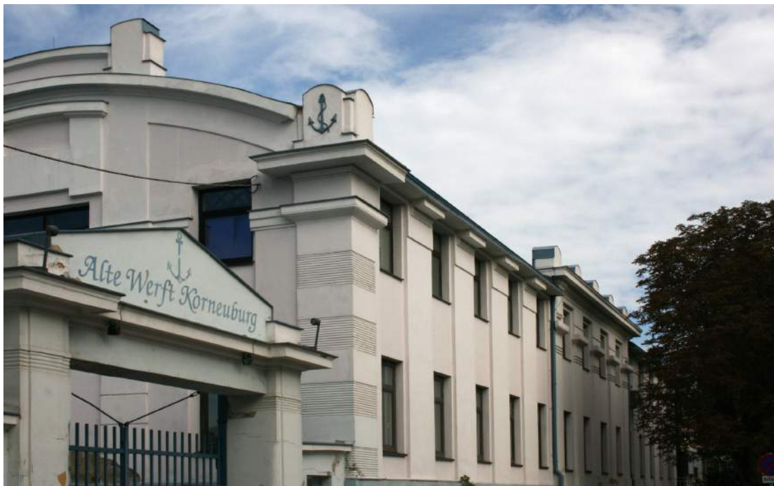
Abbildung 46: Objekt 60 bereits mit neuem Fassadenanstrich; Zustand im Jahr 2010
