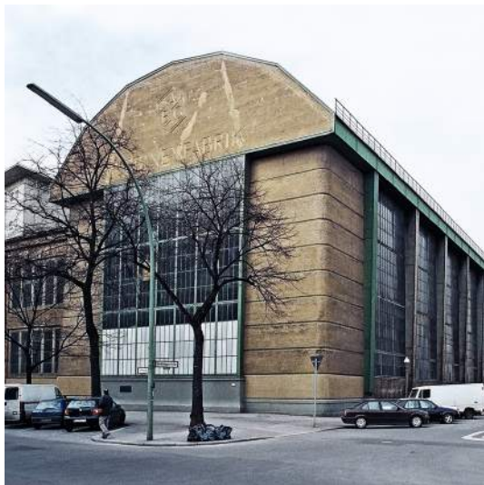
Abbildung 39: Peter Behrens Turbinenfabrik für die AEG in Berlin, 1909
