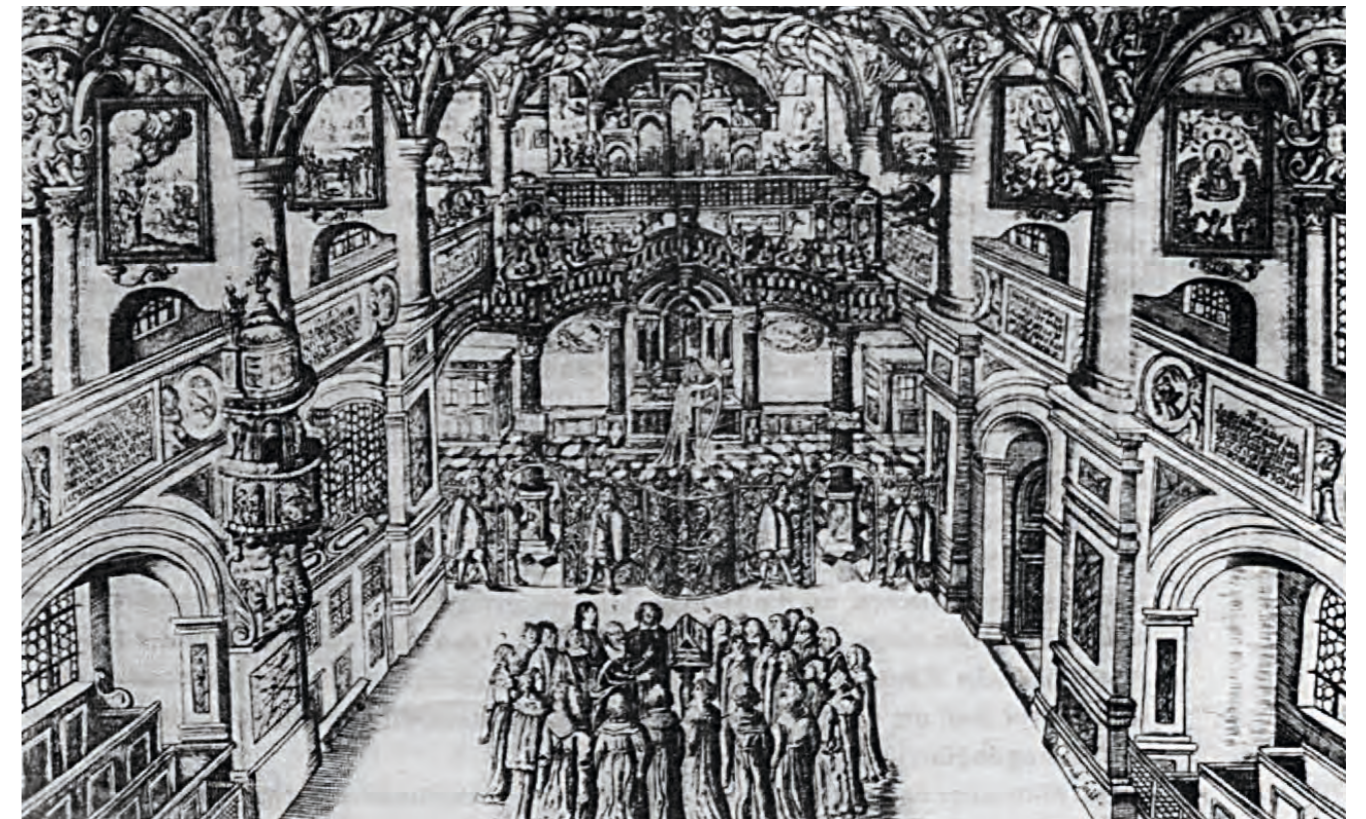
Abb. 7: Gebäude mit Höhlenakustik
