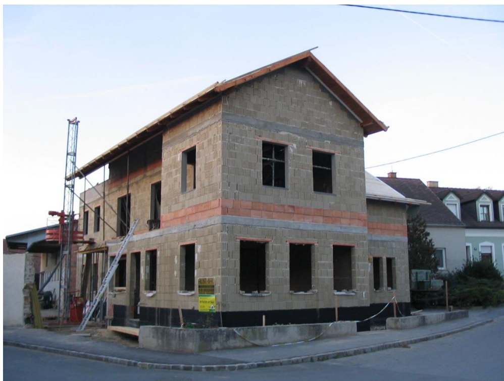
Abb.89: Rohbau Lehmziegelhaus
