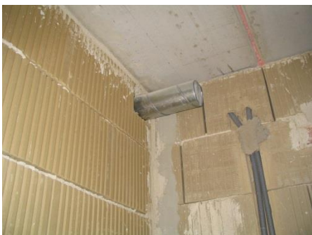
Abb.84: Detail: Fertigelemente Decke auf Lehmziegelwand
