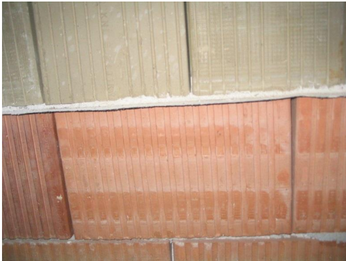
Abb. 80: zwei Reihen gebrannter Ziegel, Horizontalsperre und darüber liegender Lehmziegel
