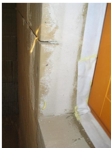
Abb.86: Fensterlaibung mit Fenstereinbau
