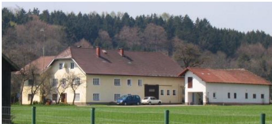
Abb.01: Bestandsgebäude W6 vor Sanierung
