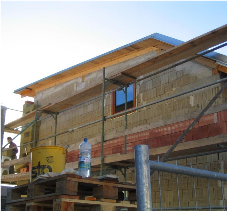
Abb.90: Rohbau Lehmziegelhaus
