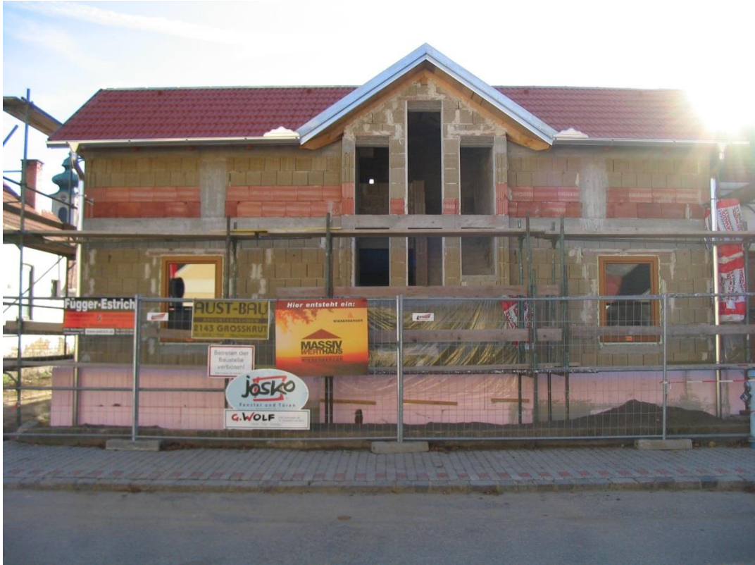
Abb.90: Rohbau Lehmziegelhaus
