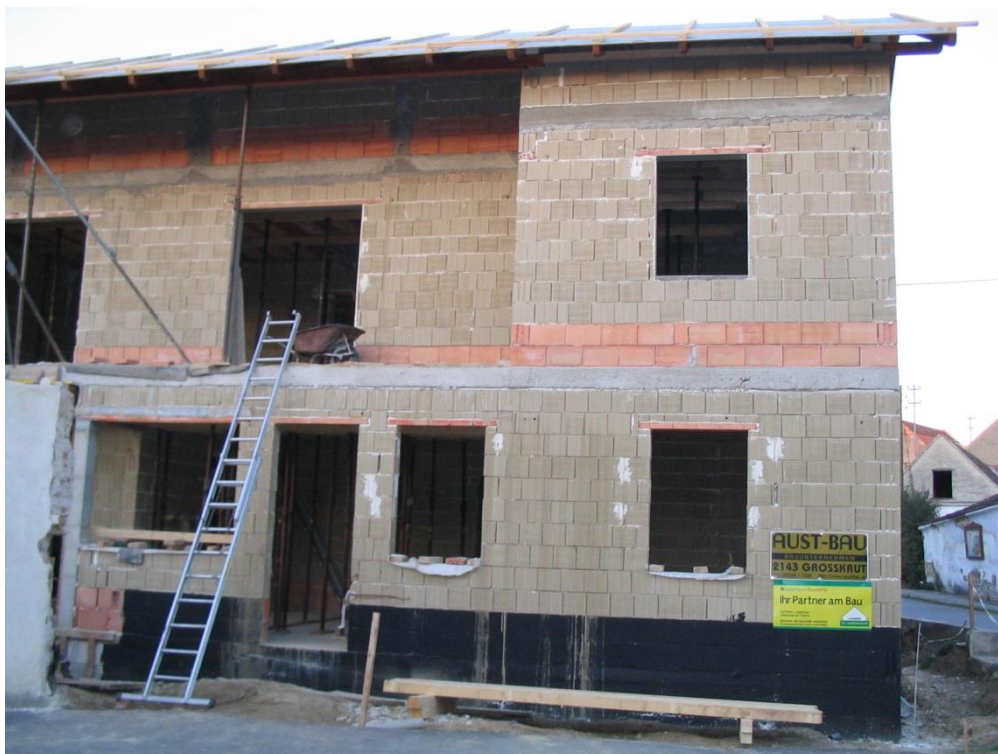
Abb.88: Rohbau Lehmziegelhaus
