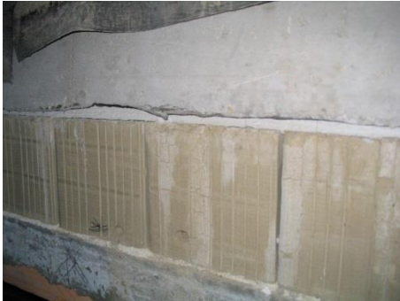
Abb.82: Betonkranz, darunter Lehmziegel
