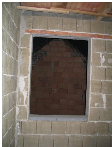
Abb.85: Fensterlaibung fertig für Fenstereinbau
