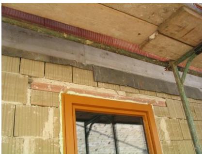
Abb.83: Betonkranz und Lehmziegel, dazwischen bituminöse Horizontalsperre
