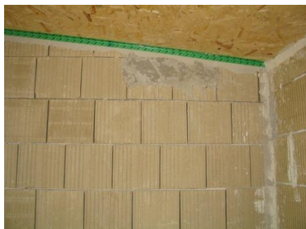
Abb.87: Deckenanschluss: Lehmziegelwand an OSB-Platten mit Abdichtklebestreifen
