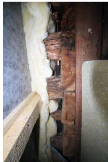
Abb. 34 Blockverband des ältesten Bereiches der Hütte
