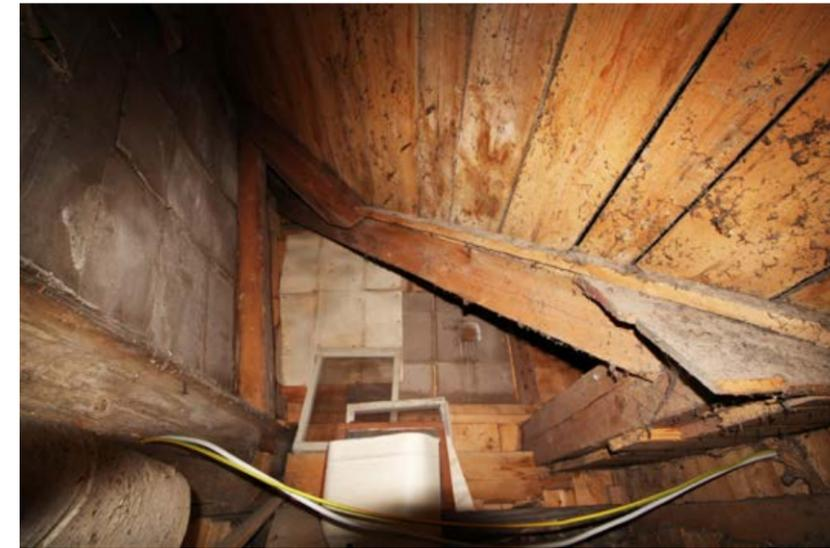
Abb. 110 Verschneidung der Dachstühle
