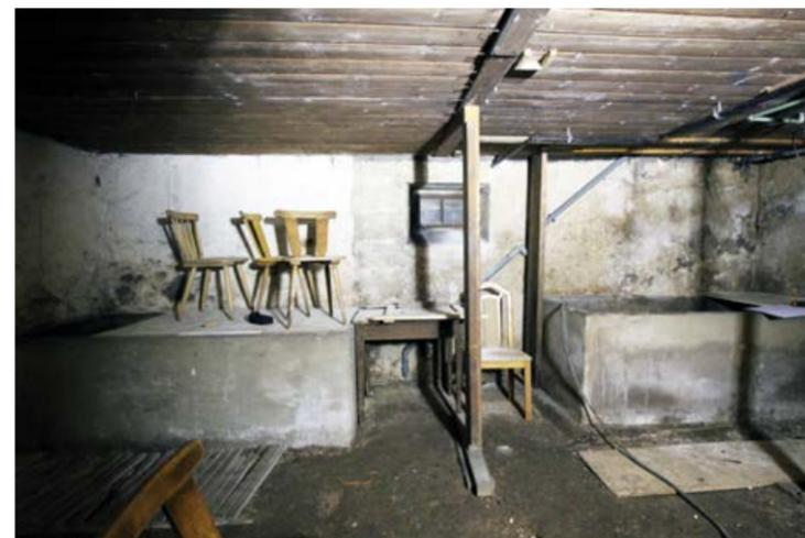
Abb. 20 Keller 1, Betontröge und Abstützung der Decke im Bereich der Bar im Erdgeschoss
