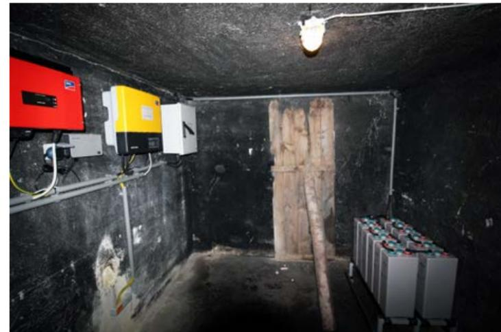
Abb. 28 PV Anlage und Batterie
