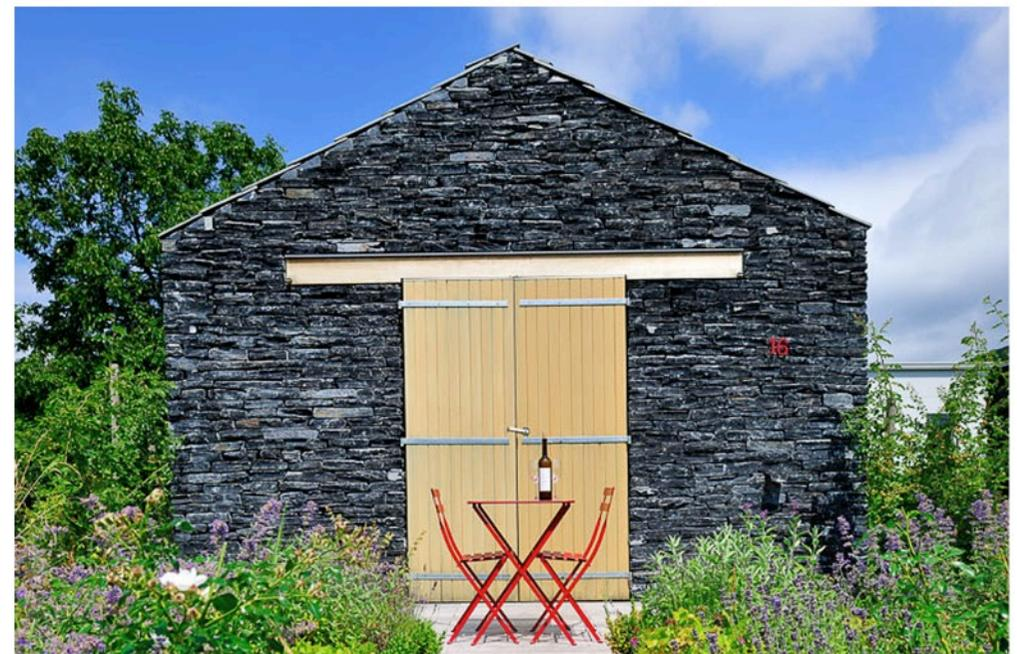
Abb.:44 Fassade aus Schiefergestein
