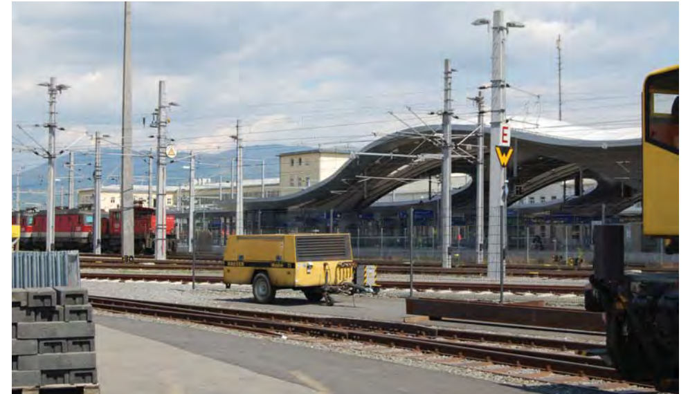
Foto 3: Blick vom Planungsgebiet auf die Bahnsteige der ÖBB
