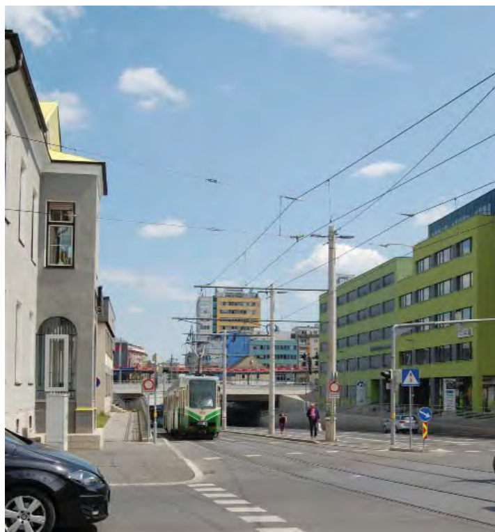
Foto 10: Blick auf die Kreuzung und die Unterführung
