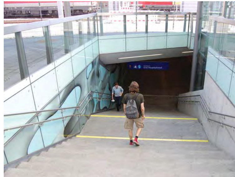
Foto 5: Abgang zum bestehenden Personentunnel
