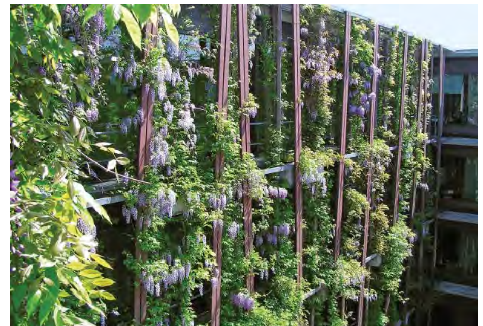
Abb.13 & 14: Ansichten der Fassade des Neubaus des Instituts für Physik der HU
