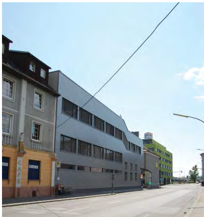
Foto 9: Blick auf des Planungsgebiet
