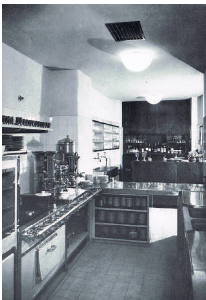
Abb.54 (oben): Restaurant Hartmann , große Schiebefenster im Ringstraßen-Restaurant im Erdgeschoss, Oswald Haerdtl, 1932.
