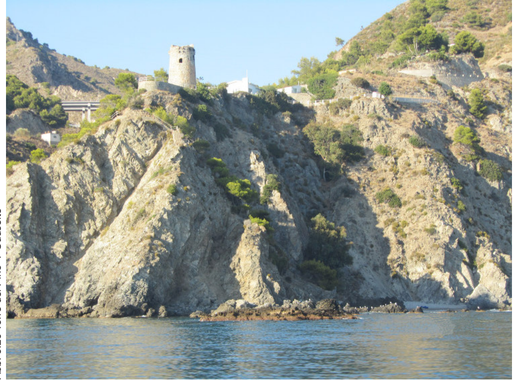
Abb. 3.26 Torre del Pino | Südseite
