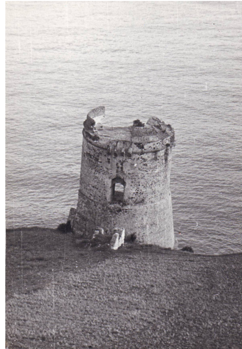
Abb. 3.25 Torre del río de la miel | Nordseite 1964
