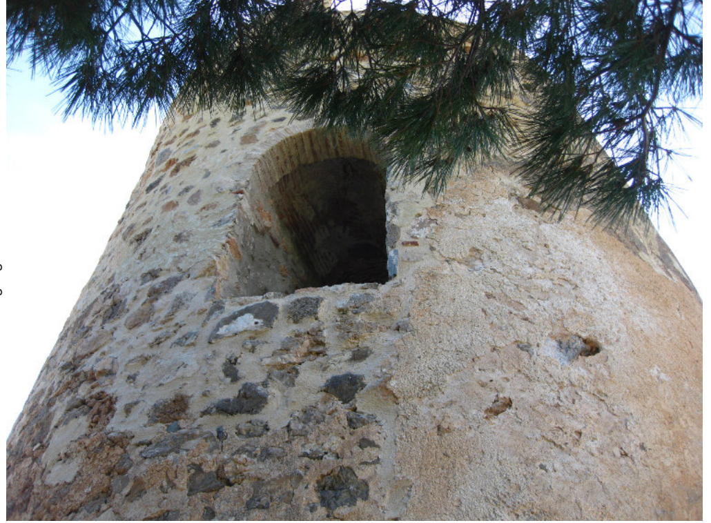
Abb. 3.28 Torre de la Caleta | Eingang Nordseite
