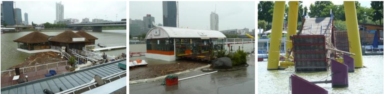
Abbildung 68: Verklausungen bei den schwimmenden Anlagen in der Neuen Donau Hochwasser Juni 2013
