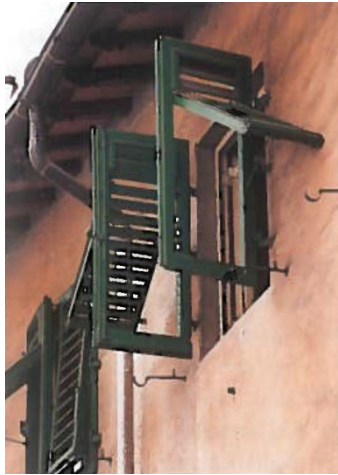
Abbildung 10: Austellbarer Fensterladen aus Holz, Rahmenkonstruktion mit Lamellen, mit Stangenschloss verschließbar. (Toskana, Italien) 29
