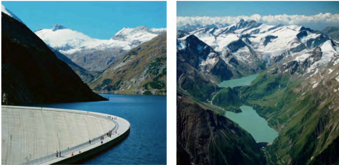
Abbildung 9 - Speicherkraftwerk Malta (links) und Kaprun (rechts), Österreich [4]
