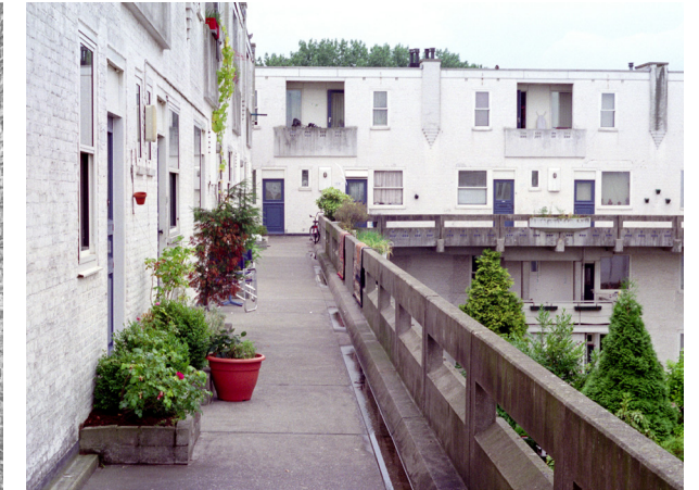
Abb. 30: Nach der Renovierung 2012 wurde der Zwischenraum wieder mit neuem Leben erfüllt: Justus van Effen Complex , Michiel Brinkman, 1922, Rotterdam – NL.
