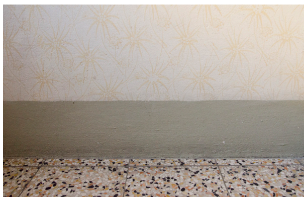
Abb. 98: Oberflächen im innenliegenden Zwischenraum: Wandoberfläche und Fußboden im Zubau.
