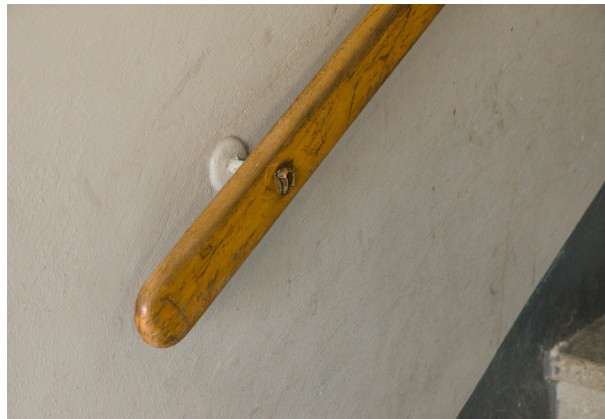
Abb. 125: Detail des hölzernen Handlaufs.
