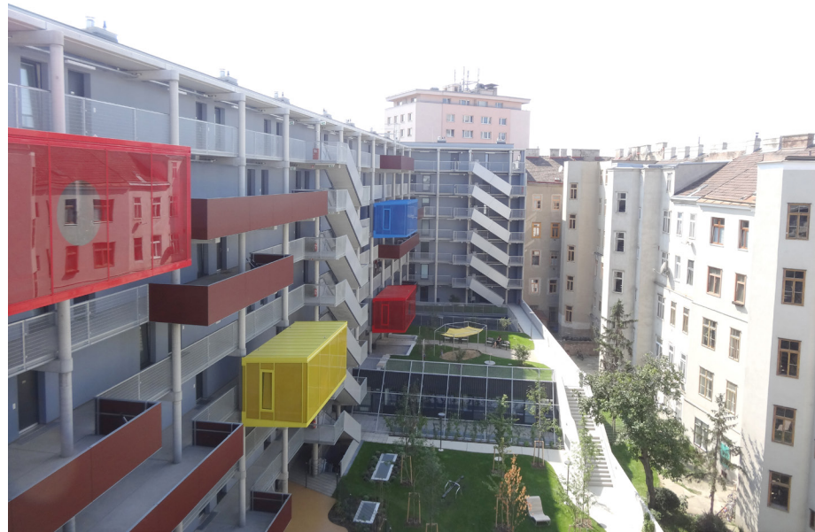
Abb. 31: Dieses Foto zeigt kurz nach dem Einzug die noch leeren Laubengänge, die bunten, multifunktionalen Raumboxen und die Zugänge zu den Wohnungen: SMART-Wohnen, Geiswinkler & Geiswinkler Architekten, 2016, Wien – AT.
