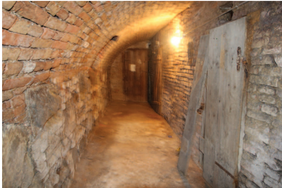
Abb.: 28 UG unter Gebäudeteil hofseitig
