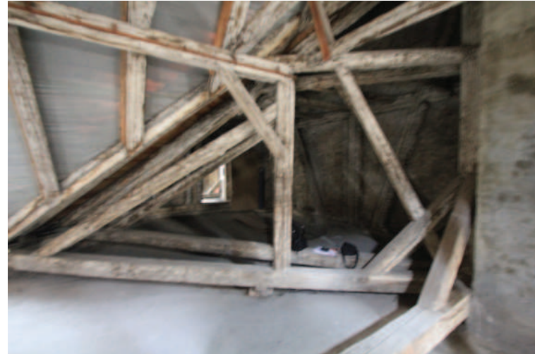
Abb.: 20 Speicher Übergang „Wiener Dachstuhl“ zu „halbes Kehlbalkendach“
