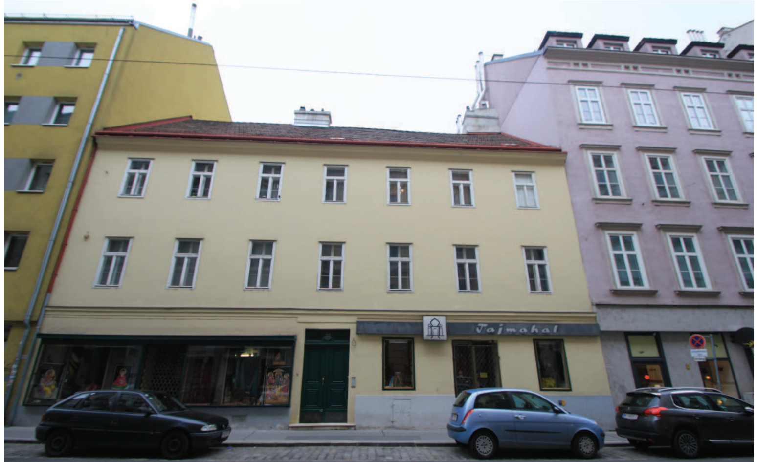
Abb.: 14 Ansicht straßenseitig, Liegenschaft Piaristengasse 33
