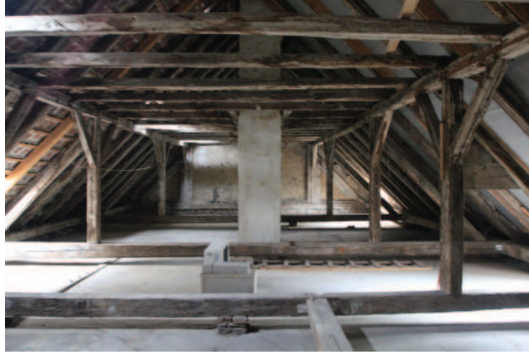
Abb.: 18 Speicher Hauptgebäude „Wiener Dachstuhl“
