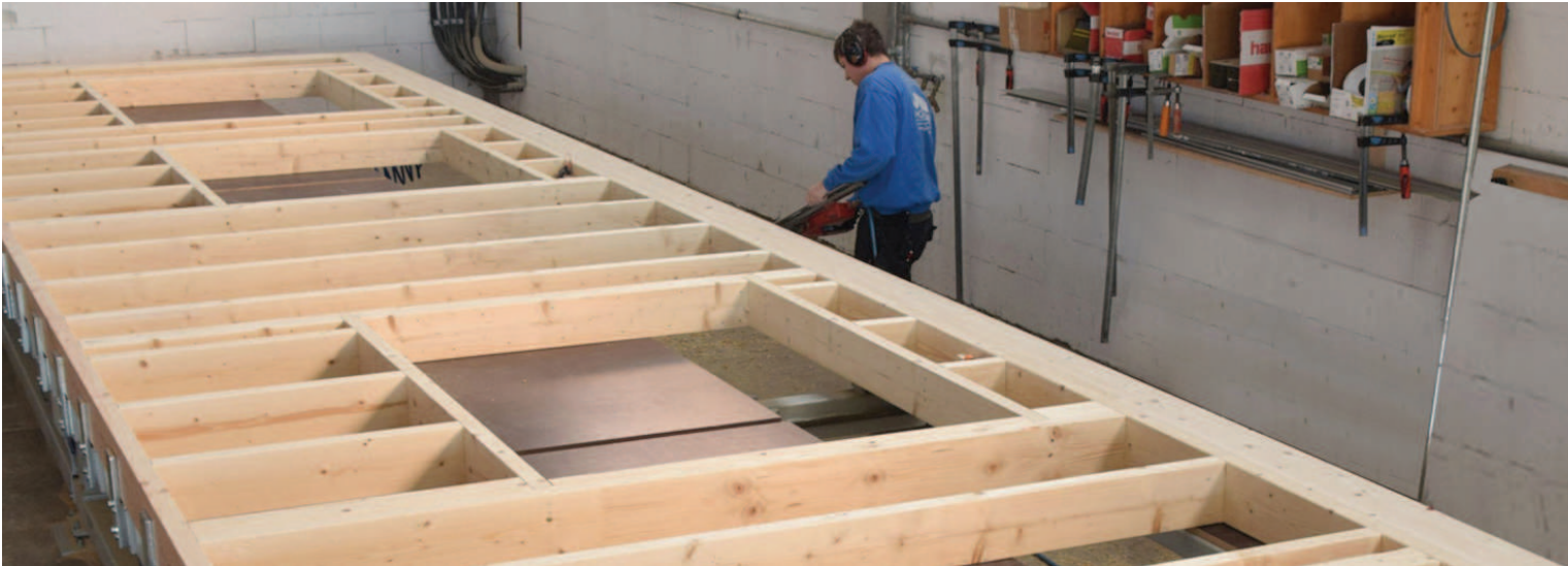
Abb.: 74 Vorfertigung eines Wandelements
