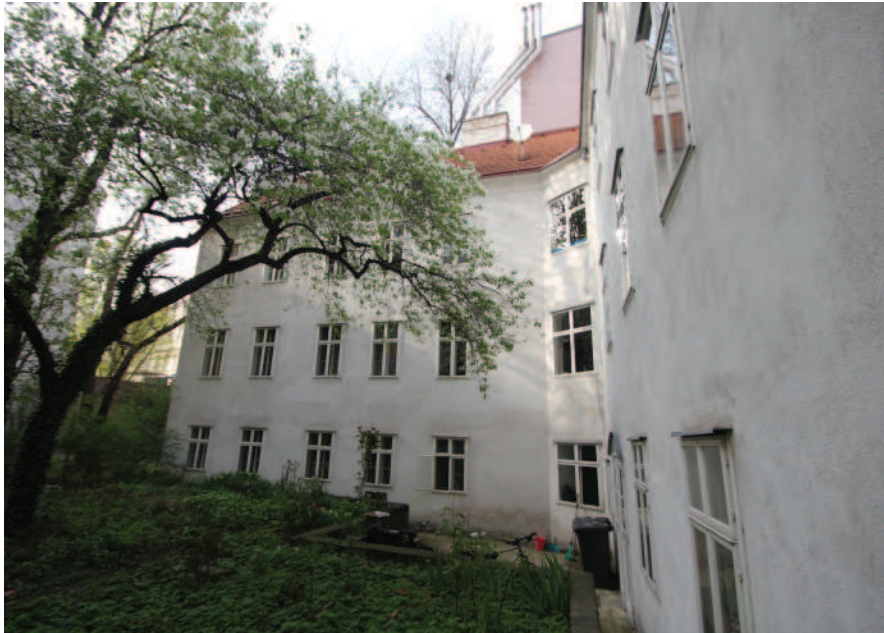
Abb.: 15 Hof der Liegenschaft Piaristengasse 33 (Westseite)
