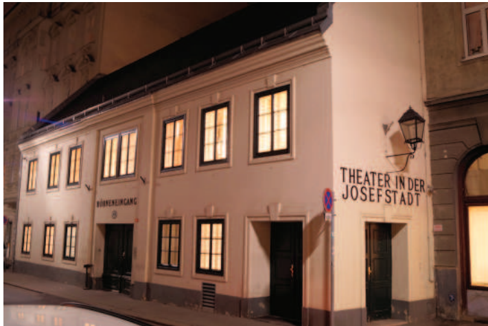
Abb.: 2 Nebengebäude des Theaters in der Josefstadt
