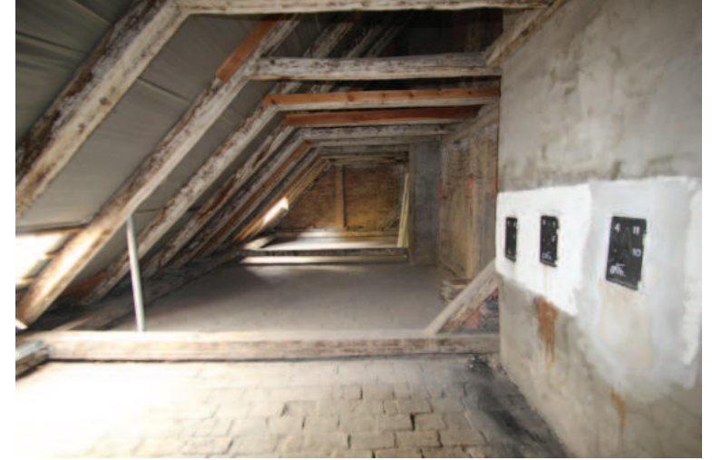
Abb.: 19 Speicher hofseitiger Gebäude- teit „halbes Kehlbalkendach“
