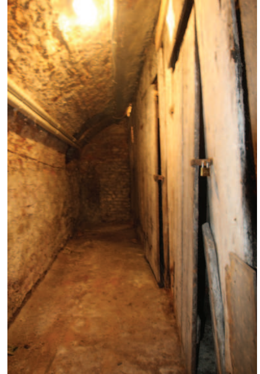
Abb.: 27 UG unter Gebäudeteil straßenseitig
