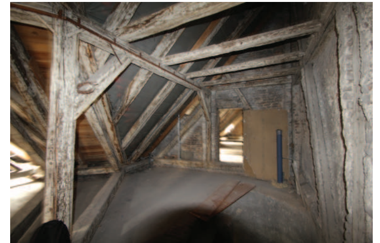
Abb.: 21 Speicher Übergang „Wiener Dachstuhl“ zu „halbes Kehlbalkendach“
