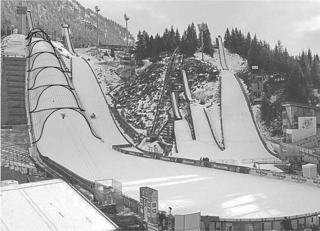
Abb. 6.41: Integration des Wind- und Witterungsschutzes an der Schattenbergschanze Oberstdorf (Deutschland)
