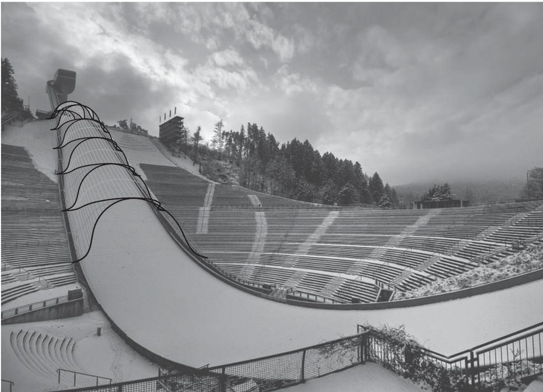
Abb. 6.43: Integration des Wind- und Witterungsschutzes an der Bergisel-Schanze Innsbruck (Österreich)
