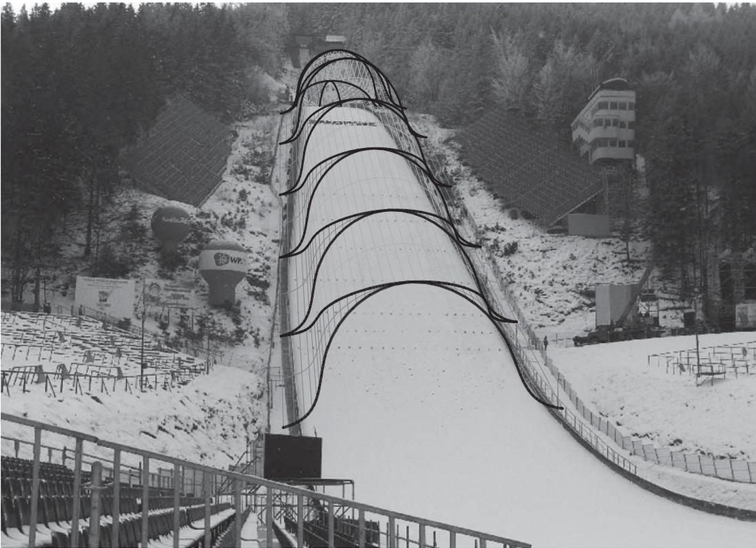
Abb. 6.45: Integration des Wind- und Witterungsschutzes an der Wielka-Krokiew-Schanze Zakopane (Polen)
