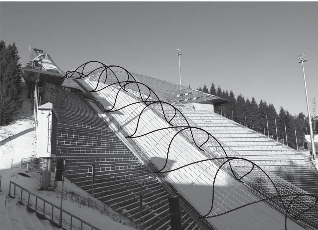
Abb. 6.46: Integration des Wind- und Witterungsschutzes an der Holmenkollen-Schanze Oslo (Norwegen)
