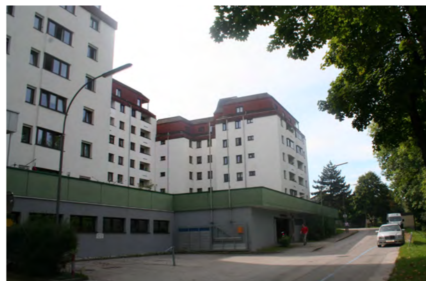
57 | angrenzender Wohnbau entlang des Bergerweges
