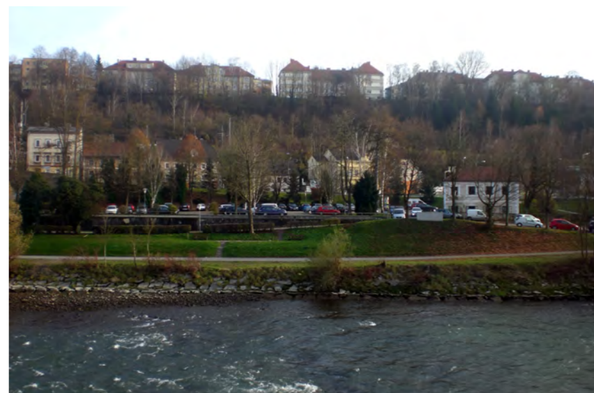
58 | Blick vom Neutor auf den Bauplatz
