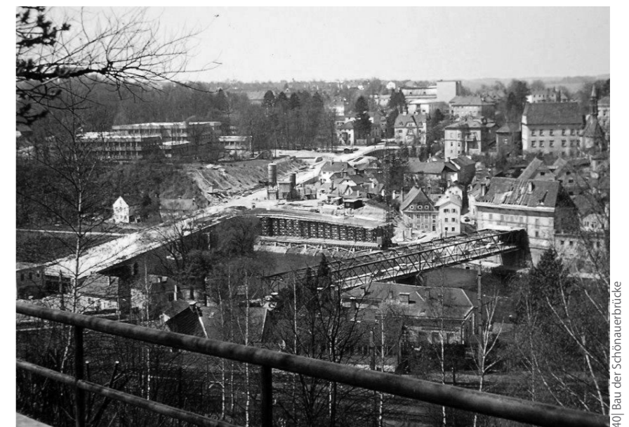
40 | Bau der Schönauerbrücke
