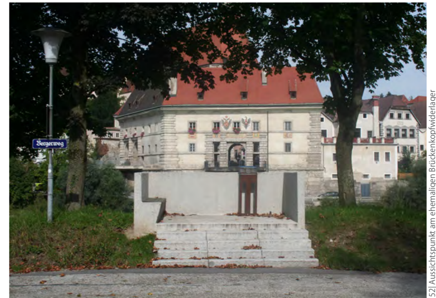
52 | Aussichtspunkt am ehemaligen Brückenkopfwiderlager
