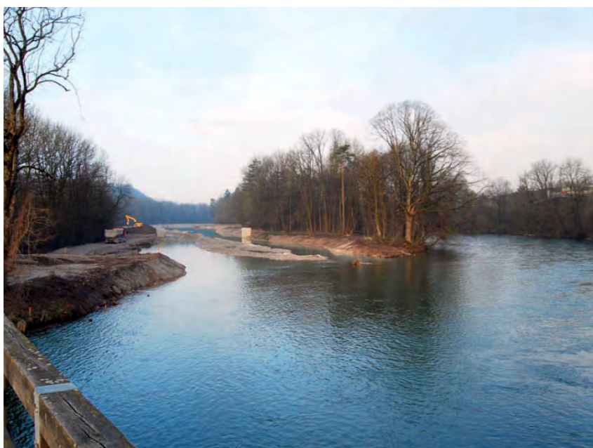
30 | Bau der Entlastungsrinne Himmlitzer Au
