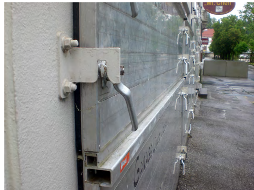
31 | mobiles Hochwasserschutzelement Ennskai
