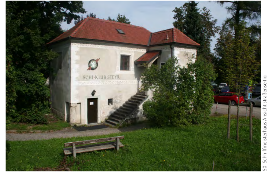
50 | Schifflmeisterhaus - Ansicht straßenseitig
