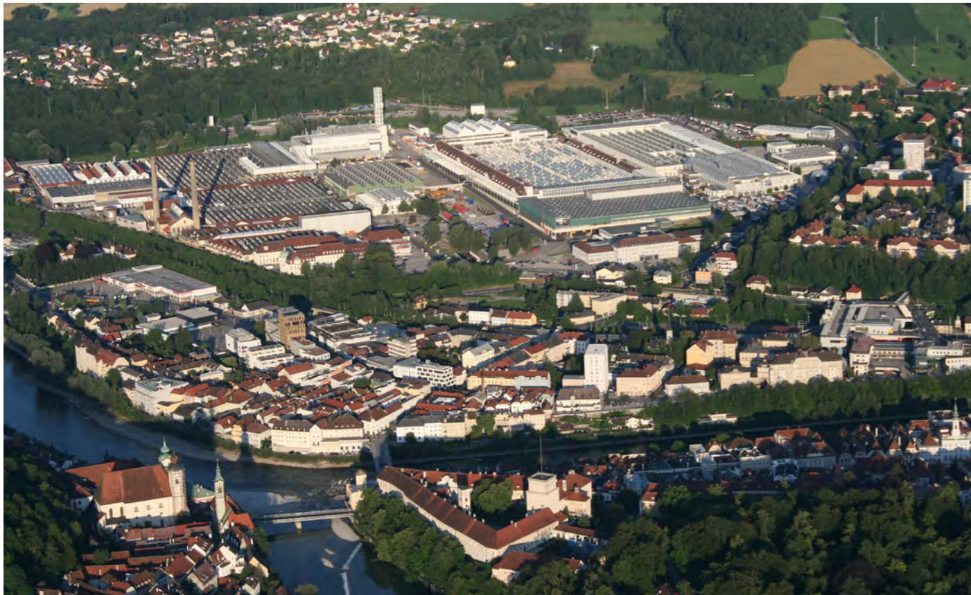
15| Blick auf die Großbetriebe MAN und ZF
