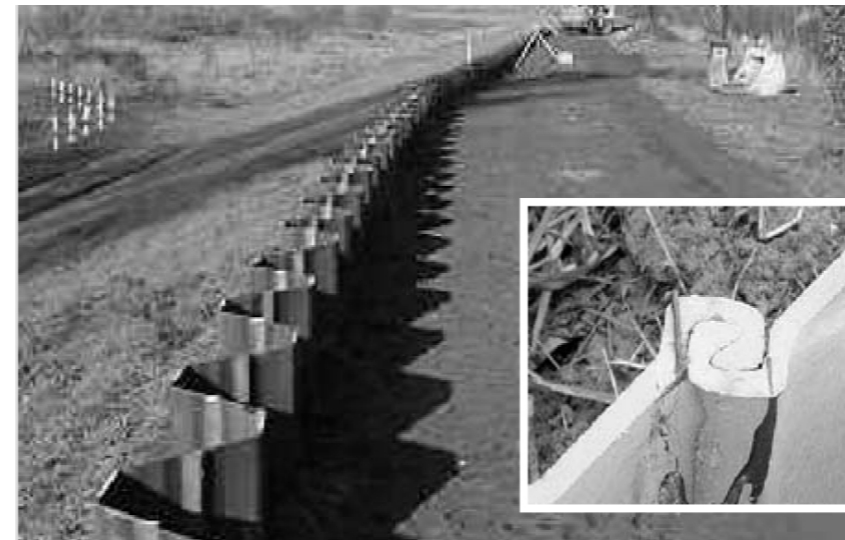
28| Spundwand in einem bestehenden Deich
