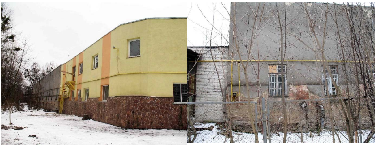
Abb. 06_05 Reste der Krenelirmauer in Kehle des Reduits. Fotos 2012.
