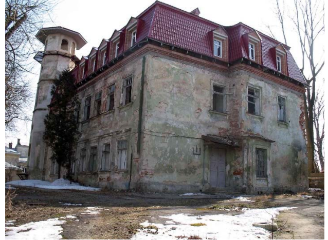
Abb. 01_27: Die erhaltene Villa aus der Mitte des 19. Jh. an Drahomanov Straße 42. Foto, 2012.
