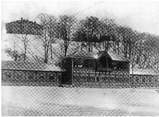
Abb. 05_06: Die Westschulter der Zitadelle und der Turm IV. 1908.
