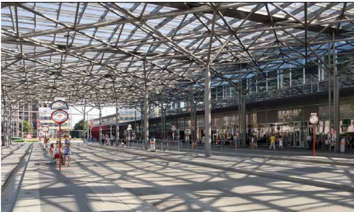
Abb. 9: Bahnhof Praterstern, Straßenbahn- und Bushaltestellen
