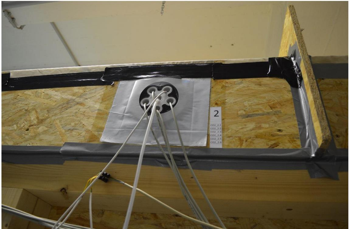
Abb. 23: Dichtungsmanschette Firma Isocell
