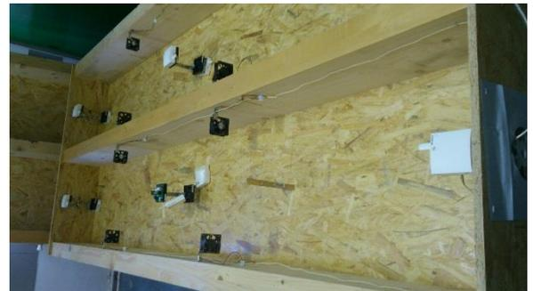
Feld in Bauzustand, Montage CO<sub>2</sub>-Sensoren und Lüfter
