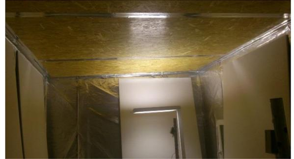
Fuge zwischen die Felder sind mit Alukleberband luftdicht abgeklebt
