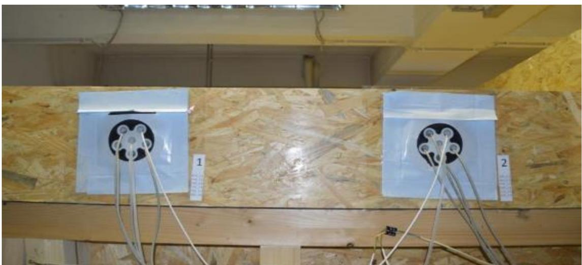
Abb. 21: Kabledurchführung in den Dachgefächern mit einer Kabelmanschette, luftdicht angeschlossen
