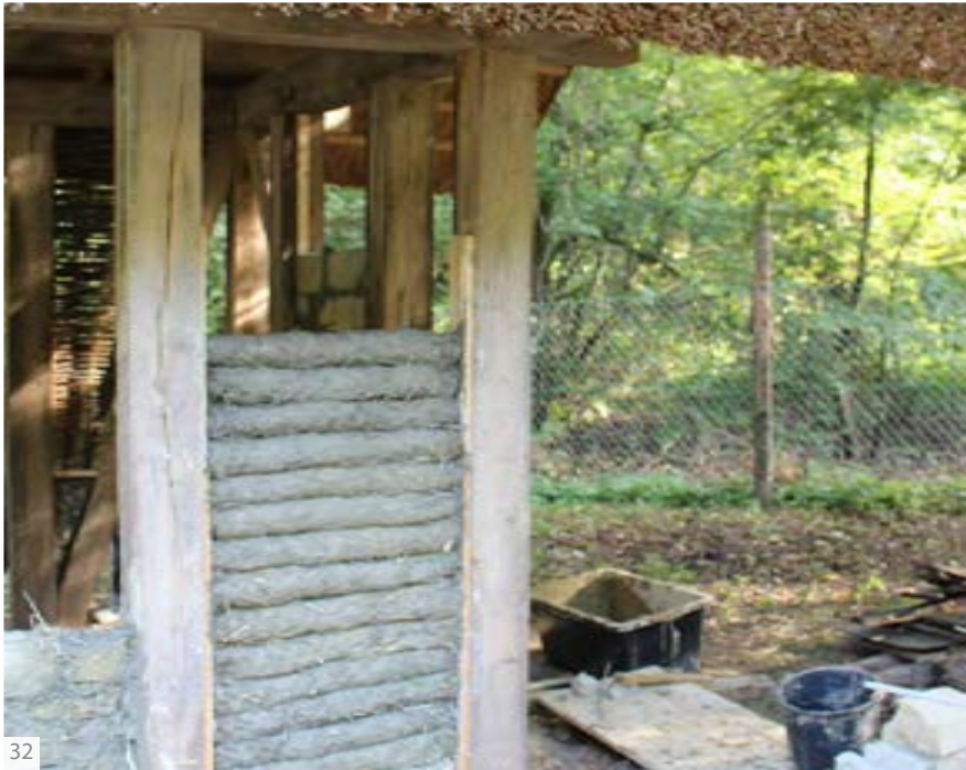
Abb. 03.32: Wickelstaken als Ausfachungstechnik
