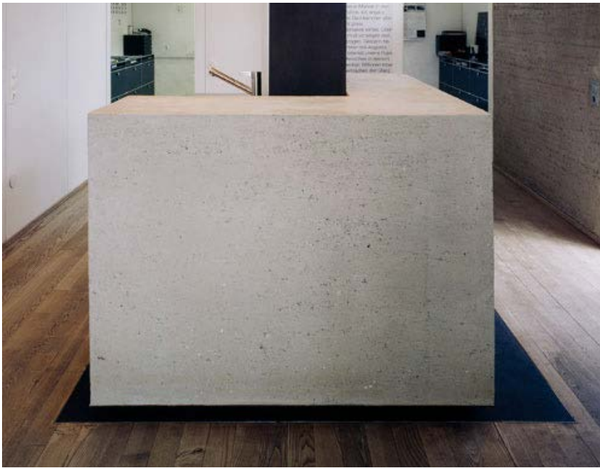
Abb. 02.45: Ofenkörper mit Stampflehm-Schale und ruhiger Oberfläche
