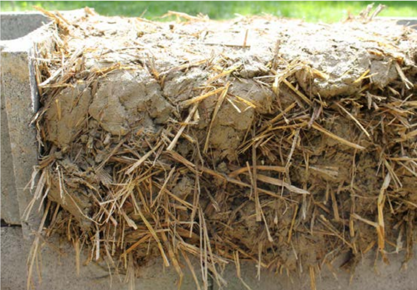
Abb. 03.16: Wellerlehmwand in der letzten Trocknungsphase bevor sie abgestochen wird
