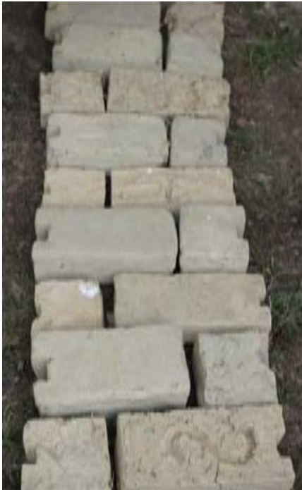
Abb. 03.25: Vorbereitung der Ziegel zum Vermauern
