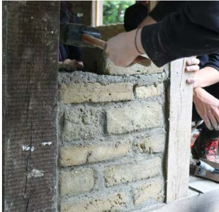
Abb. 03.26: Lehmziegelmauer mit Lehmörtel
