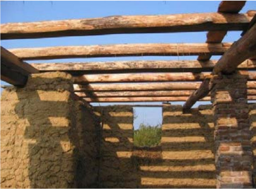
Abb. 02.7: Lehm- und Holzbau in Gyűrűfű
