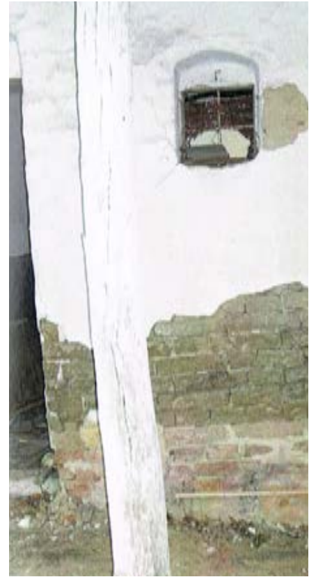
Abb. 02.11: Lehmwand in seinem Originalzustand in einem Streckhof in Hörersdorf, Fußpunkt aus gebrannten Ziegel
