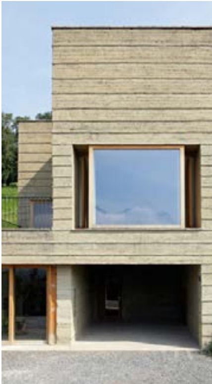
Abb. 02.35: Haus Rauch, Ansicht auf die massive Stampflehmwand
