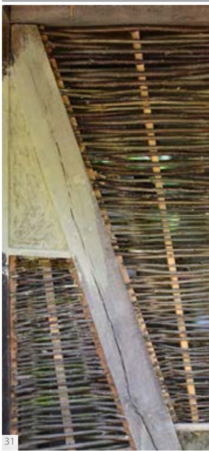
Abb. 03.31: Flechtwerkwand mit Lehmewurf aus dem Workshop in Sopron
