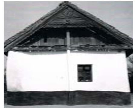
Abb. 03.2: das ausgefüllte Lehmhaus aus Dulovce, SK aus Stampflehm mit aufgebaute Holzdachstuhl
