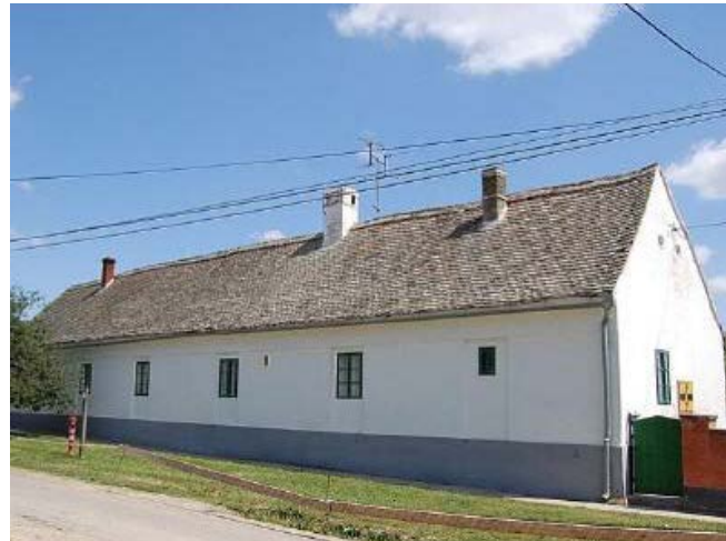
Abb. 02.34: Neuer Dachstuhl mit Überstand; Überdachung der befestigten Fläche im Außenbereich
