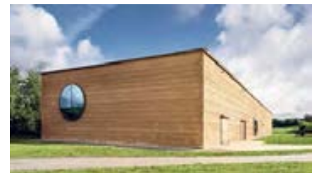
Abb. 02.36: Ricola Kräuterzentrum in Basel Abb. 02.37: Produktionshalle der Stampflehm- melemente für die Fassade des Kräuterzentrums Abb. 02.38: ein Stampflehmelement mit einem Gewicht von fünf Tonnen
