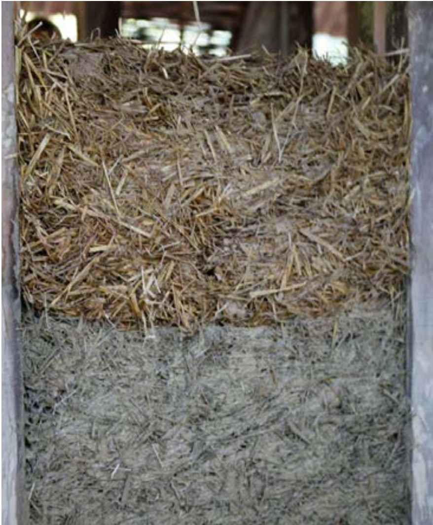
Abb. 03.35: Leichtlehmwand in unterschiedlichen Mischungsverhältnissen als Ergebnis der Lehm bauworkshops
