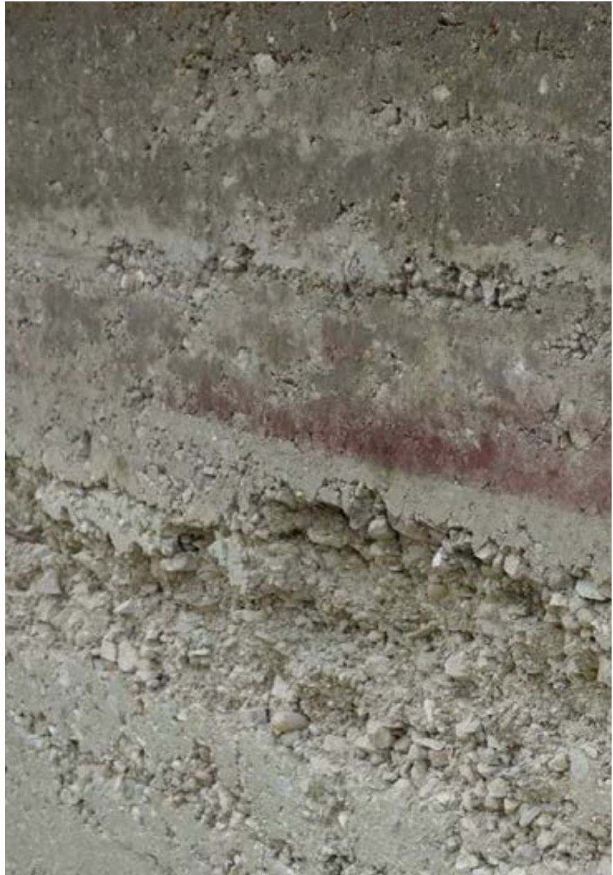
Abb. 01.5: Stampflehmwand in zwei Bauphasen mit Austrocknungsphase über den Winter; unten bis zum Farbstreifen Phase I; ab dem Farbstreifen Phase II
