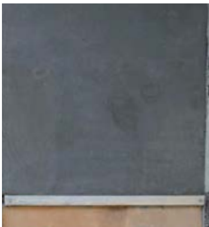
Abb. 03.40: Feinputz im unteren Bereich mit Farblasur Abb. 03.41: Grobputz mit Stroh
