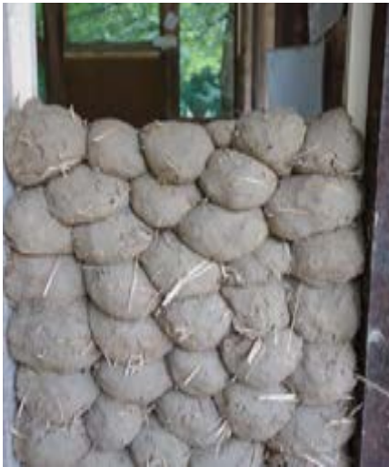
Abb. 03.29: Wuzelmauer aus dem Lehmworkshop in Sopron
