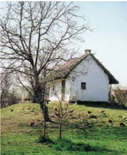
Abb. 03.10: Landhaus aus Wellerlehmwänden in Homorúd, Ungarn
