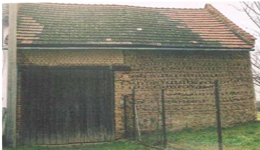
Abb. 03.27: Detail eines Lehmputzenbaus in Niederösterreich
