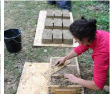
Abb. 03.21: Vermengen von Lehm | Sand | Stroh
