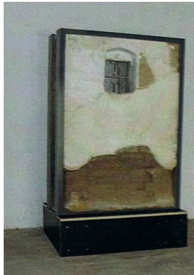
Abb. 02.12: translozierte Lehmwand als Teil der Lehmausstellung im Museumsdorf Niedersulz
