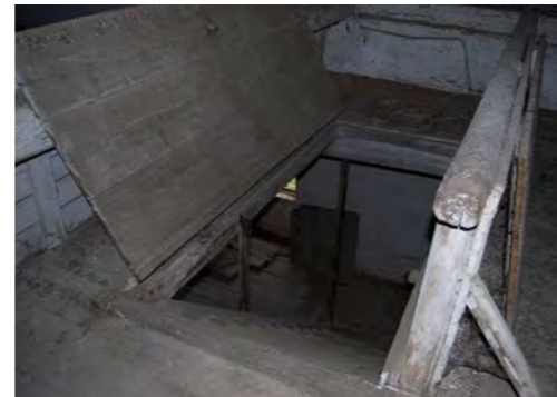
Abb. 143 Holzstiege ins 1.OG mit Falltür
