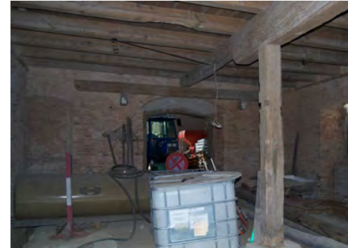
Abb. 53 unverputztes Ziegel- und Mischmauerwerk, Holztramdecke, Holzstütze mit Ausklinkungen
