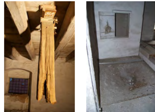
Abb. 122 und 123 Decken- und Fußbodendurchbrüche und Schacht
