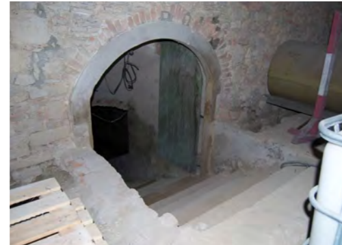
Abb. 57 Kellerabgang T01, Portal mit Steinlaibung und Ziegelbogen
