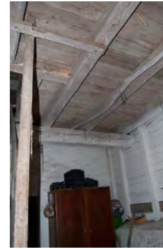
Abb. 103 und 104 l: Raumnr. R11, Stiegenaufgang vom EG ins 1.OG r: Holzbalkendecke mit offener Untersicht
