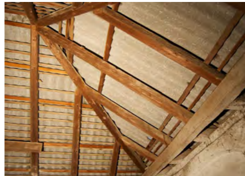
Abb. 139 Dachstuhlkonstruktion (Krüppelwalmdach)
