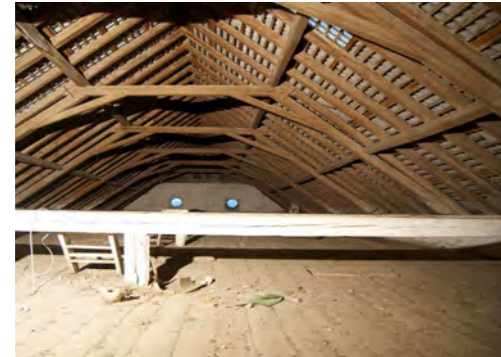
Abb. 132 Raumnr. R14, Pfeftendach mit doppelt liegendem Dachstuhl, zimmermannsmäßige Verbindungen
