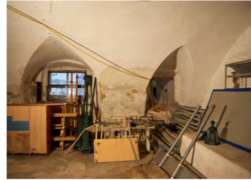
Abb. 75 Öffnungen F05 und F06, rechts im Bild: Aufbau über Kellerabgang
