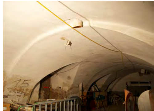
Abb. 80 Übergang von Tonnen- in Kreuzgratgewölbe auch am Deckenversprung ersichtlich
