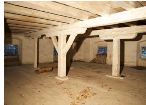
Abb. 110 Raumnr. R12, Schüttboden, Holztramdecke auf Holzstützen unterschiedlichen Querschnitts mit Kopfbändern und Sattelhölzern
