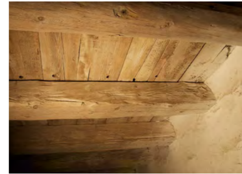
Abb. 115 Holztramdecke, Träme auf Außenwänden aufgelagert
