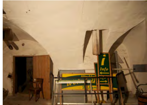
Abb. 77 Öffnung T07 und Nische N07, dazwischen Deckendurchbruch
