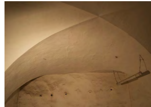
Abb. 86 Raumnr. R06, Kreuzgratgewölbe
