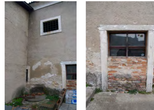
Abb. 32 und 33 l: Südfassade, Öffnungen F05, F06 und F24 r: Öffnung F06, Parapet nachträglich aufgemauert
