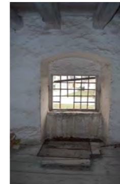
Abb. 111 und 112 l: Stütze mit Ausklinkungen r: Öffnung F21 mit Steckgitter
