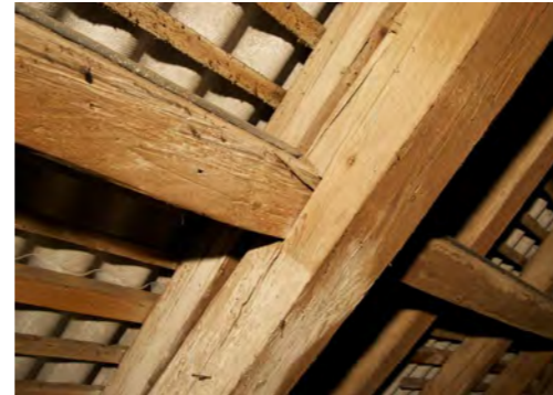
Abb. 137 Detailsicht Stuhlsäule - Mittelfette
