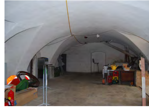
Abb. 69 Tonnengewölbe mit Stichkappen, Mauerwerk mit Verputz und Anstrich
