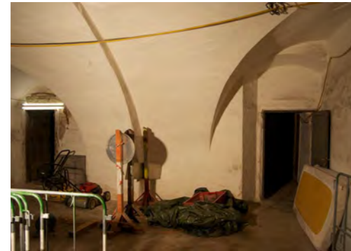
Abb. 79 Öffnungen T08 und T09, Gewölbeansätze: links Tonnengewölbe, rechts Kreuzgratgewölbe
