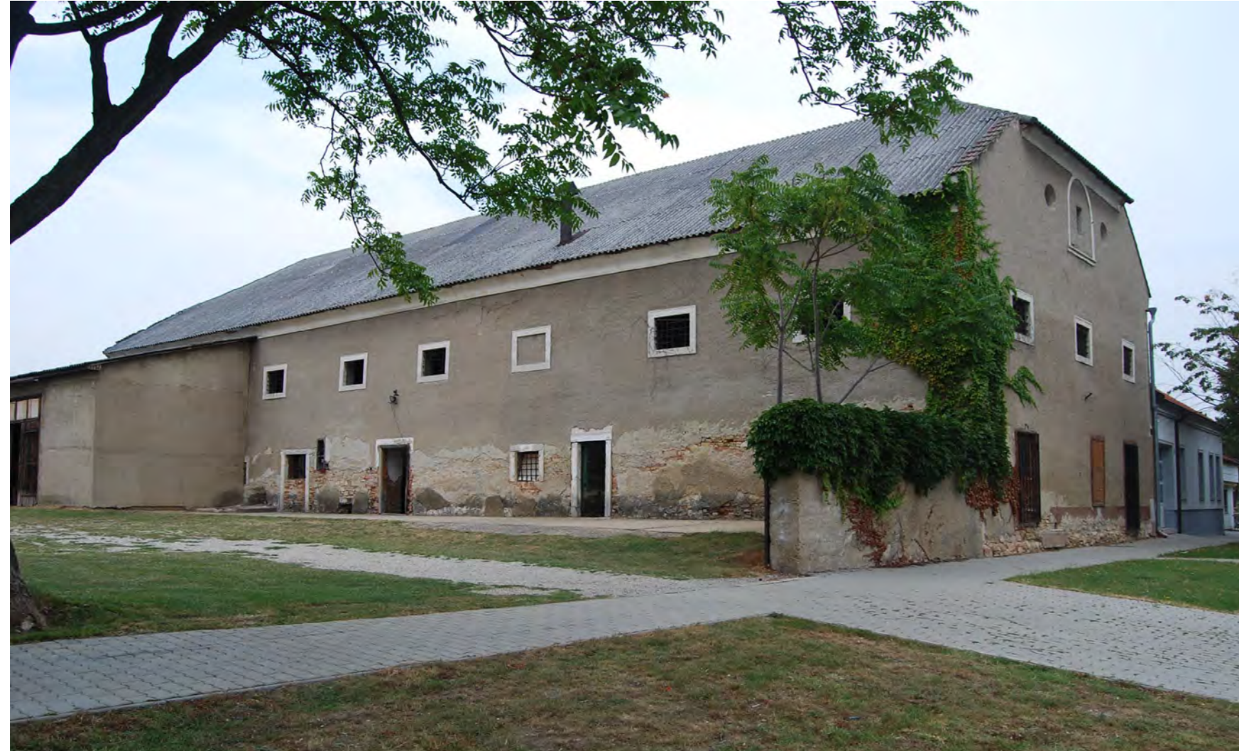
↑ Abb. 25 Der Schüttkasten in Mönchhof, Süd- und Ost- fassade
