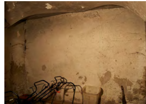
Abb. 82 Raumnr. R05 mit Kreuzgratgewölbe, Innenwand verläuft im Gewölbestich, links im Bild: zugemauerte Öffnung
