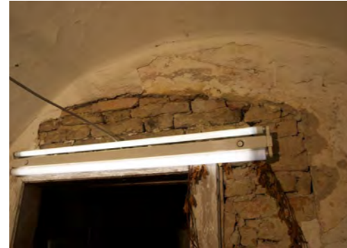
Abb. 78 Öffnung T08 vermutlich nachträglich verkleinert, sichtbares Ziegelmauerwerk mit durchlaufender Fuge, kein Verband
