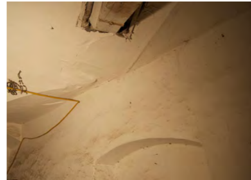
Abb. 81 Kreuzgratgewölbe, Innenwand zu R11 verläuft im Gewölbestich, Nische N08
