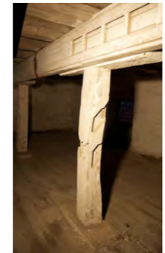
Abb. 111 und 112 l: Stütze mit Ausklinkungen r: Öffnung F21 mit Steckgitter
