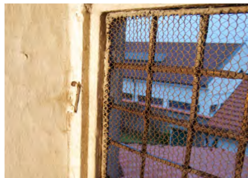
Abb. 130 Detailsicht Steckgitter, verankert in Steinlaibung, Drahtgitter und Fensterreiber
