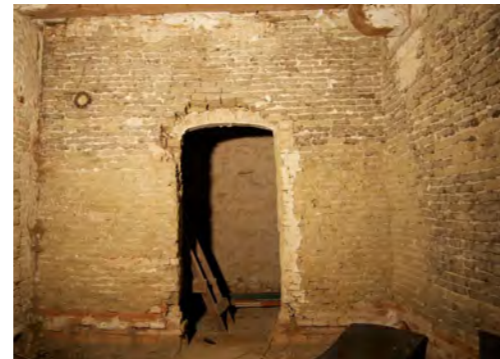
Abb. 63 Öffnung T02, gräuliche Ziegel, dieser Ziegeltyp wurde nur bei diesen beiden Wänden und bei Zumauerung verwendet
