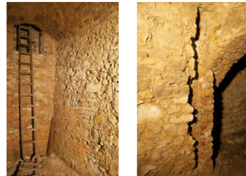
Abb. 51 und 52 Detailansicht zusätzlicher Ausstieg an der nördlichen Längsseite
