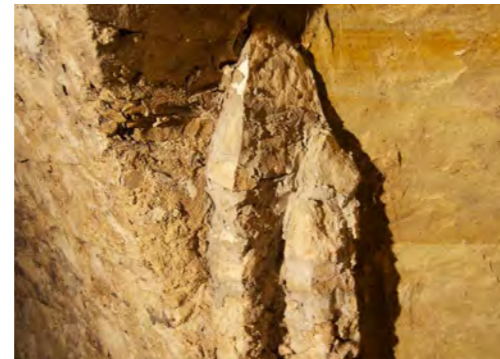
Abb. 47 N02, Detailansicht Mauerwerk und Erdreich
