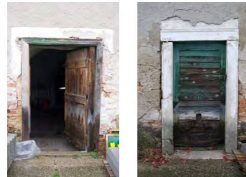
Abb. 34 l: Südfassade, Öffnungen T06 r: Öffnung T15
