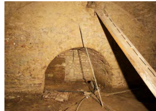
Abb. 50 Detailansicht N04 an der östlichen Stirnseite, Rückseite der Nische vermutlich nachträglich zugemauert
