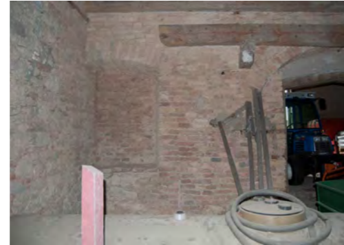
Abb. 54 Öffnung T04 und Nische N06, unverputztes Mauerwerk, deutlich erkennbare Mauerwerksabschnitte
