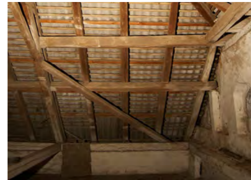
Abb. 138 Dachstuhlkonstruktion (Krüppelwalmdach) und Giebelwand der Ostfassade
