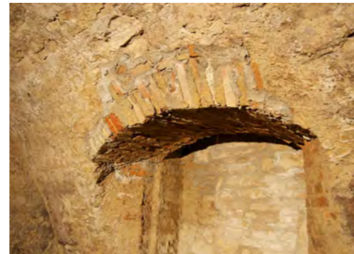
Abb. 48 N03, Detailansicht der abgemauerten Nische, Verwendung unterschiedlicher Steinarten und -formate
