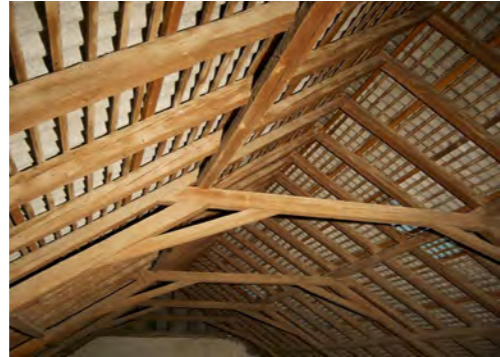
Abb. 133 Detailsicht Spannriegel und Stuhlsäule
