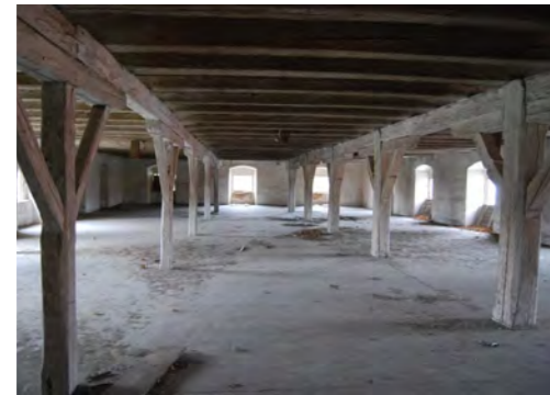
Abb. 116 Raumnr. R13, Schüttboden, Holztrammede auf Holzstützen mit zwei unterschiedlichen Querschnitten, Betonboden
