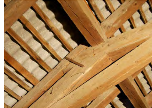
Abb. 134 Detailsicht vermutlich nachträgliche Verklammerung
