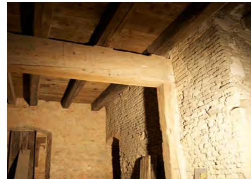
Abb. 68 Ziegelmauerwerk unterschiedl. Farbe (Außenwand rötlich, Innenwand gräulich) rechts im Bild: Abrisspuren einer Innenwand
