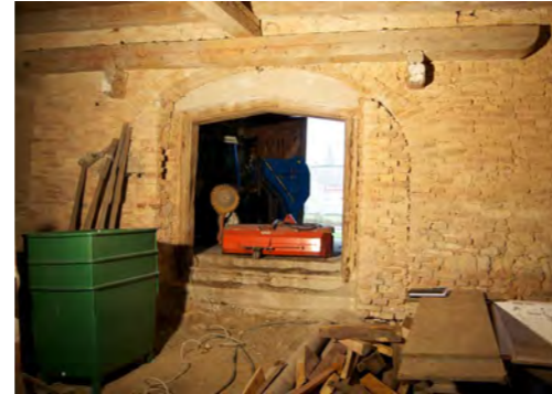
Abb. 55 Öffnung T04 durch nachträglichen Anbau verkleinert, Holzkonsolen und -balken dienen als Auflager für die Holztramdecke
