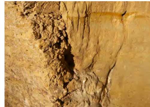
Abb. 46 N01, Detailansicht Mauerwerk und Erdreich
