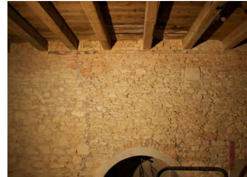
Abb. 56 Mischmauerwerk, unterschiedliche Steinarten und -formate, mögliche Bauphasen sind hier ablesbar
