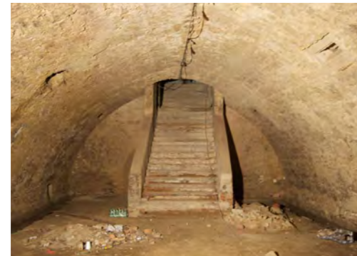
Abb. 40 Tonnengewölbe des Kellers, Bruchsteinmauerwerk mit Lüftungsöffnungen, Kellerstiege an der westl. Stirnseite
