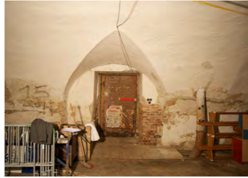
Abb. 70 Öffnung T06, derzeitiger Haupteingang vom Vorplatz ins EG
