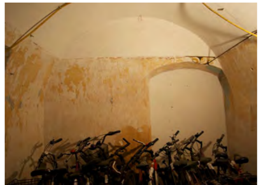
Abb. 92 Nische N09, Mauerwerk mit Verputz und Anstrich
