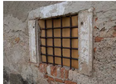
Abb. 35 Südfassade, Öffnung F07 im EG
