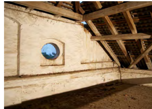
Abb. 140 Öffnung F38, Dachstuhlkonstruktion (Krüppelwalmdach) und Giebelwand der Ostfassade
