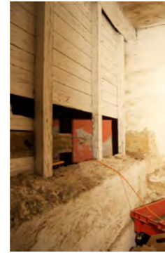
Abb. 105 und 106 l: betonierter Sockel und Holzständerkonstruktion r: Putzschaden
