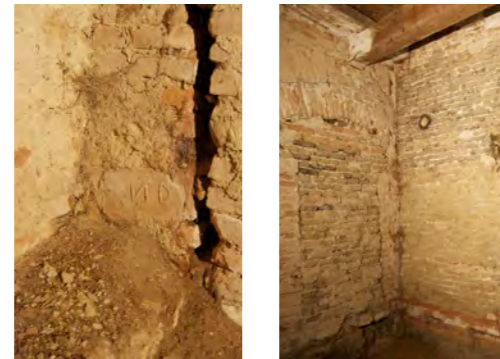
Abb. 61 und 62 l: Ziegel mit Prägung ND (vermutlich für „Neusiedl“) r: zugemauerte Öffnung
