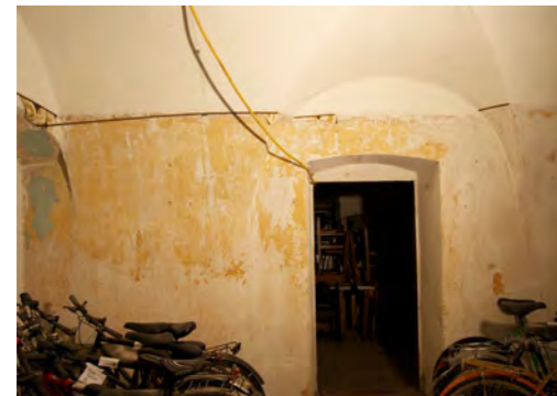
Abb. 91 Raumnr. R08, Öffnung T10, Tonnengewölbe mit Stichkappen
