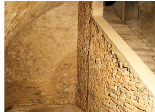
Abb. 42 unverputztes Mauerwerk, rundbogenförmige Öffnung an der westlichen Stirnseite vermutlich nachträglich zugemauert
