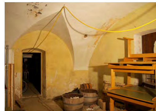
Abb. 95 Öffnungen T11 und F12, Tonnengewölbe mit Stichkappen, Mauerwerk mit Verputz und Anstrich
