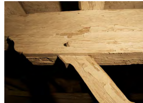
Abb. 120 Detailsicht zimmermannsmäßige Verbindung Kopfband und Sattelholz mit Holznaegel
