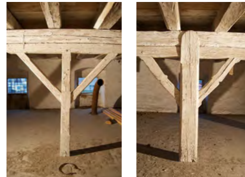
Abb. 118 und 119 Detailsicht der zwei Stützentypen mit Kopfbändern und Sattelholzern
