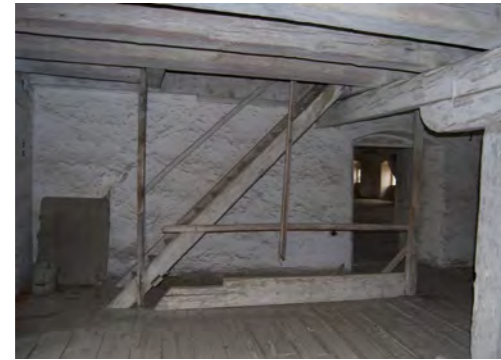
Abb. 113 Öffnung T17 und Holzstiege vom 1.OG in DG
