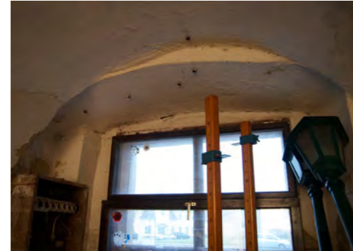
Abb. 76 Öffnung F06, Überlappung Gewölbe - Entlastungsbogen, links im Bild: E-Verteiler
