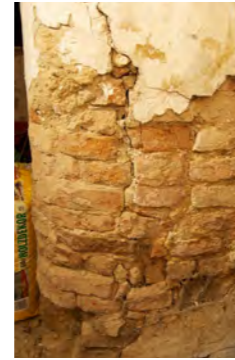
Abb. 105 und 106 l: betonierter Sockel und Holzständerkonstruktion r: Putzschaden
