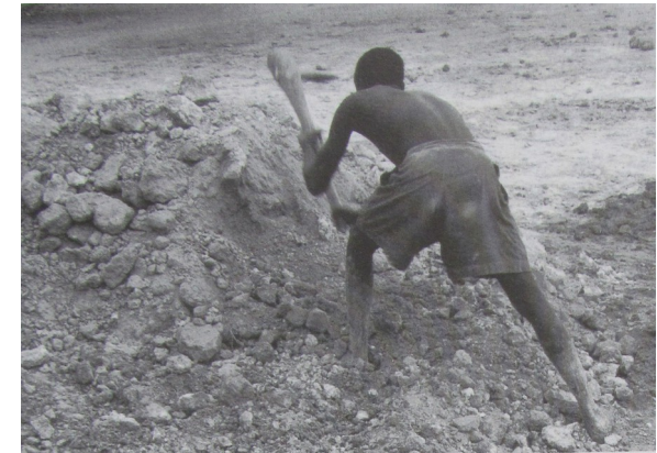
Abb. 22 Zerkleinern der Erde aus der Lehmgrube
