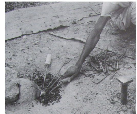
Abb. 31 Nägel aus Eisen für Verstärkungsarbeiten
