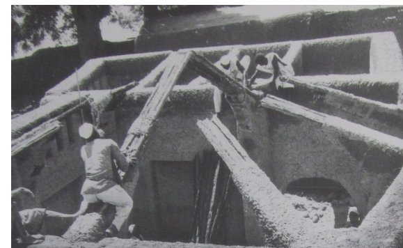
Abb. 44 Bauphasen eines Kuppeldaches
