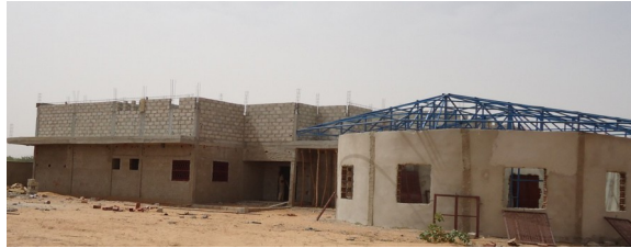
Abb. 132 Konstruktion Schwesternhaus, Kapelle verputzt
