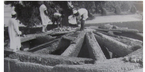
Abb. 46 Bauphasen eines Kuppeldaches
