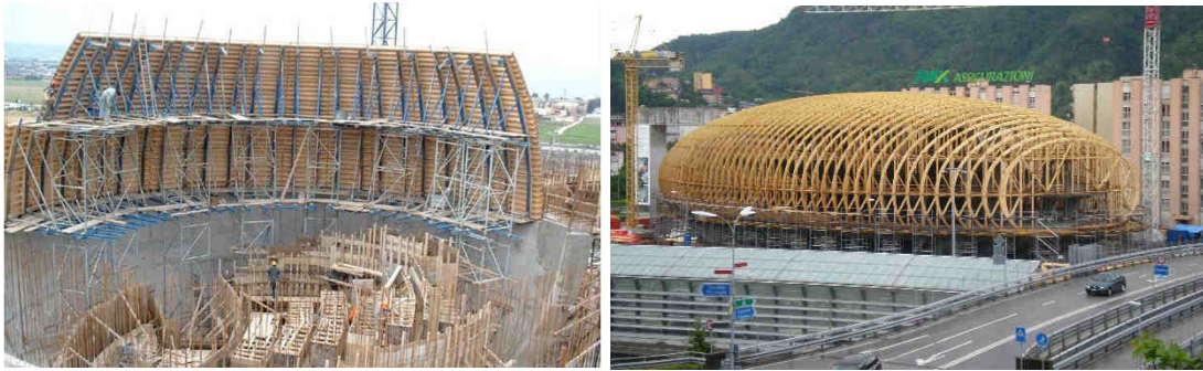
Abbildung 3 Holzschalung und Lehrgerüst (links © doka, rechts © Aurelio Muttoni) [12], [20]
