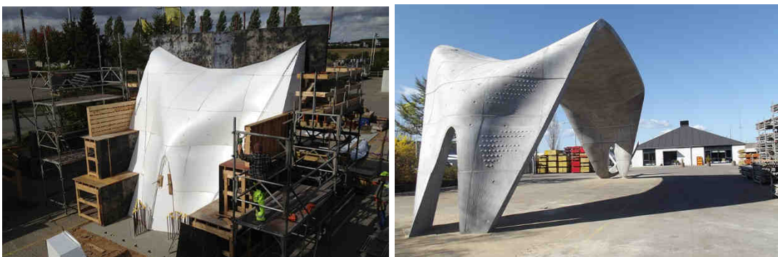
Abbildung 4 Eine freigeformte Schalungskonstruktion aus Styroporblöcken ©Paschal (Styroporschalung links, fertig gestellte Betonstruktur rechts) [27]
