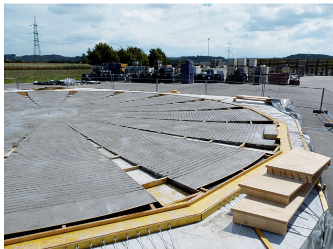
Bild 9 Fertig betonierete Platte mit den eingedrückten Sollbruchstellen Ready casted concrete plate with the predetermined breaking lines
