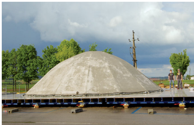
Bild 14 Außenansicht der fertiggestellten Schale Exterior view of the finished shell structure
