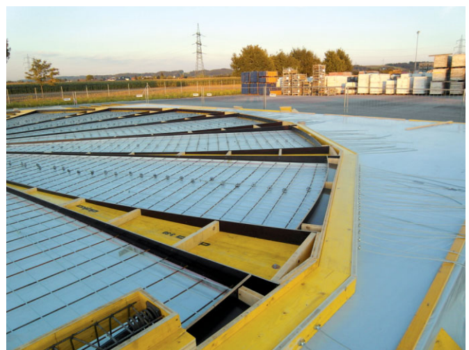
Bild 8 Schalung mit der fertig eingebauten Bewehrung Formwork with the ready mounted reinforcement
