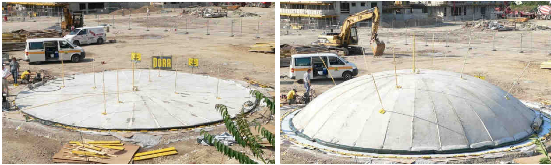
Abbildung 9 Versuchsschale mit Styroporkeilen (links ebene Platte, rechts fertig verkrümmte Schale)
