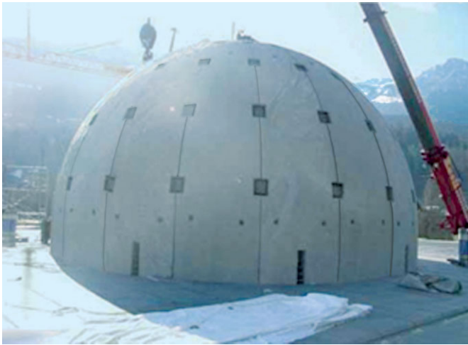
Bild 1 Thermenanlage Bad Hofgastein, Betonschale aus Fertigteilen Thermal spring Bad Hofgastein, concrete shell out of prefabricated concrete parts
