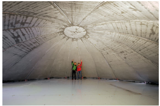
Bild 10 Fertiggestellte Schale im Innenbereich Finished shell structure interior view
