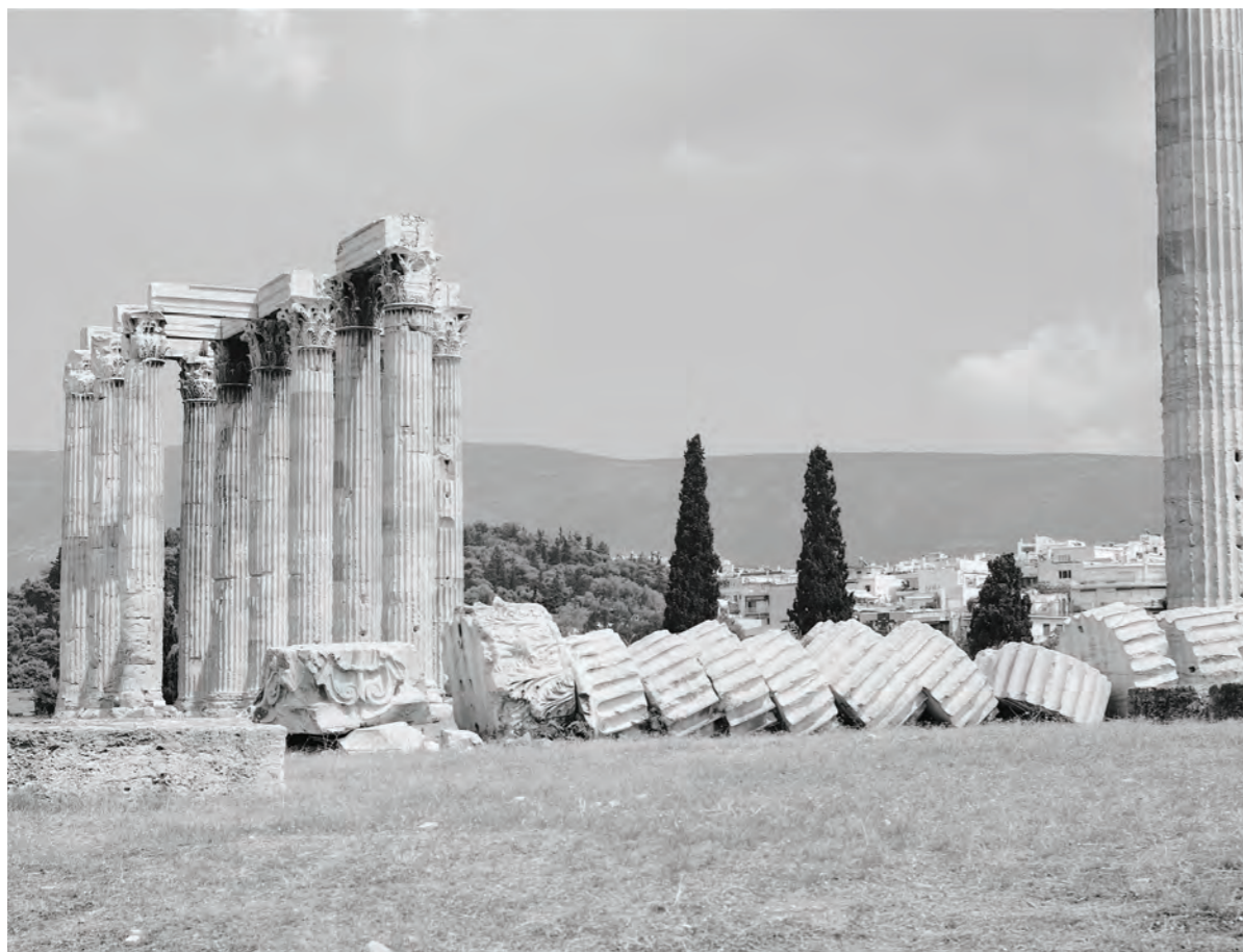
Abb.11 – An einer umgestürzten Säule des Olympieion in Athen ist der Aufbau aus vorgefertigten Steinsegmenten klar ablesbar.
