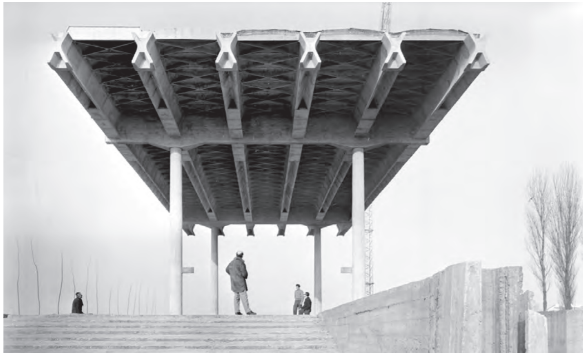
Abb. 20 – Rohbau der Kirche in Baranzate.
