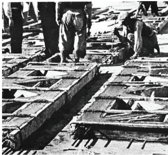
Abb.12-14 – Flugzeughangar in Orbetello. Vorfertigung der einzelnen Fertigteilsegmente vor Ort am Boden. Detail eines Knotenpunkt der anschließend mit Ortbeton vergossen wird.
