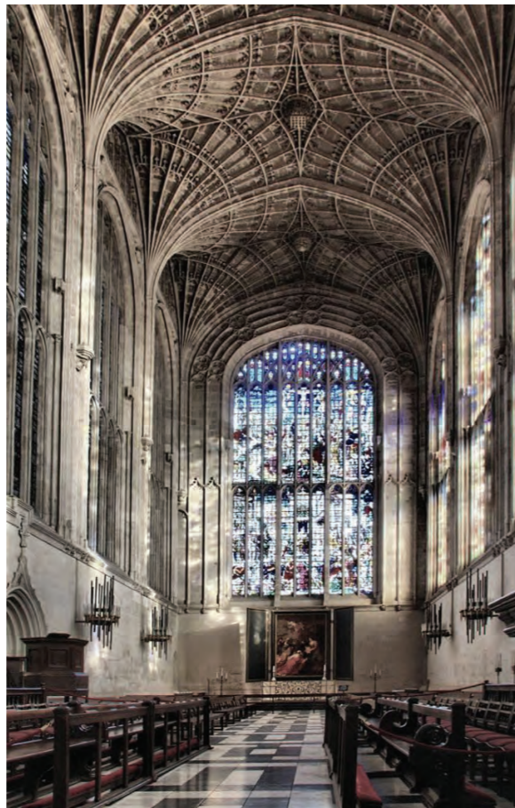
Abb.16 – Das dekorative Fächergewölbe der King's College Chapel in Cambridge ist inspiriert von rein statischer Intuition
