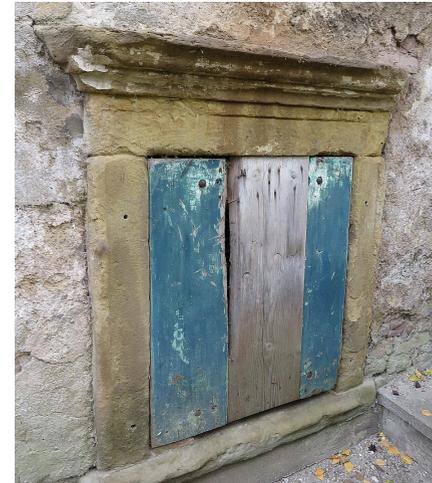
Abb. 137: Fenster mit Steingewände im EG
