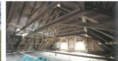
Abb. 22: Liegende Stuhlkonstruktion
