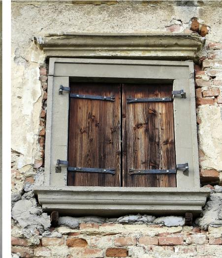
Abb. 136: Fenster mit Betongusselementen im Obergeschoss
