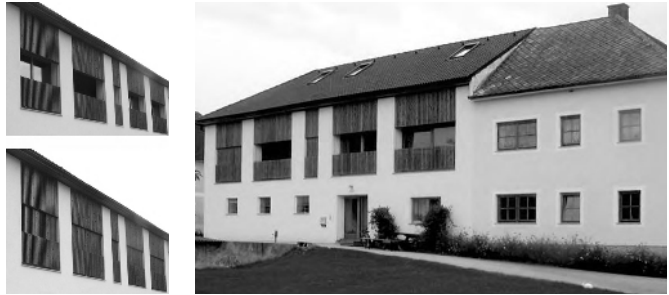
1.18 | Fassade mit beweglichen Sonnenschutzelementen
